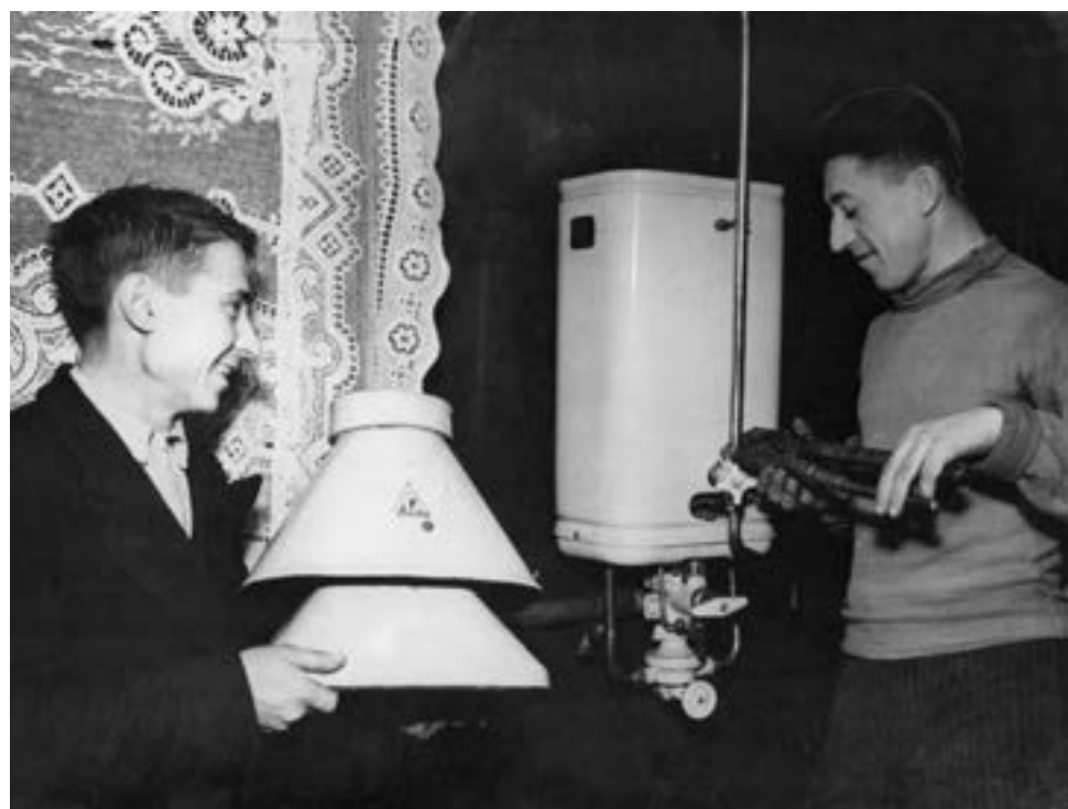
Газ в быту. Установка газовой колонки в квартире рабочего завода зубострогальных станков. 1951
