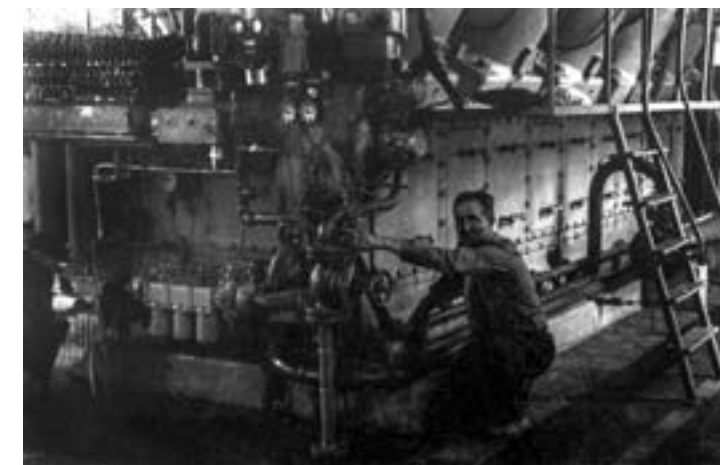
Компрессорный цех Кирсановского ЛПУМГ. 1950 -е годы
