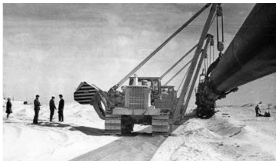
Строительство газопровода Средняя Азия – Центр IV
