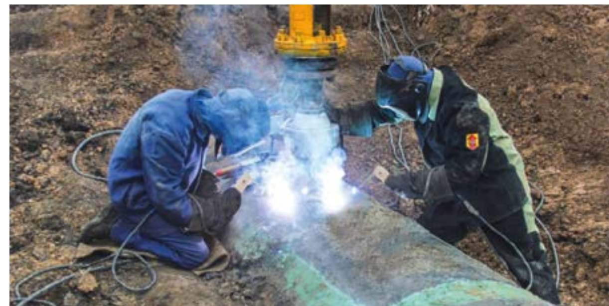
Ремонтные работы на ГРС «Гремячий»
