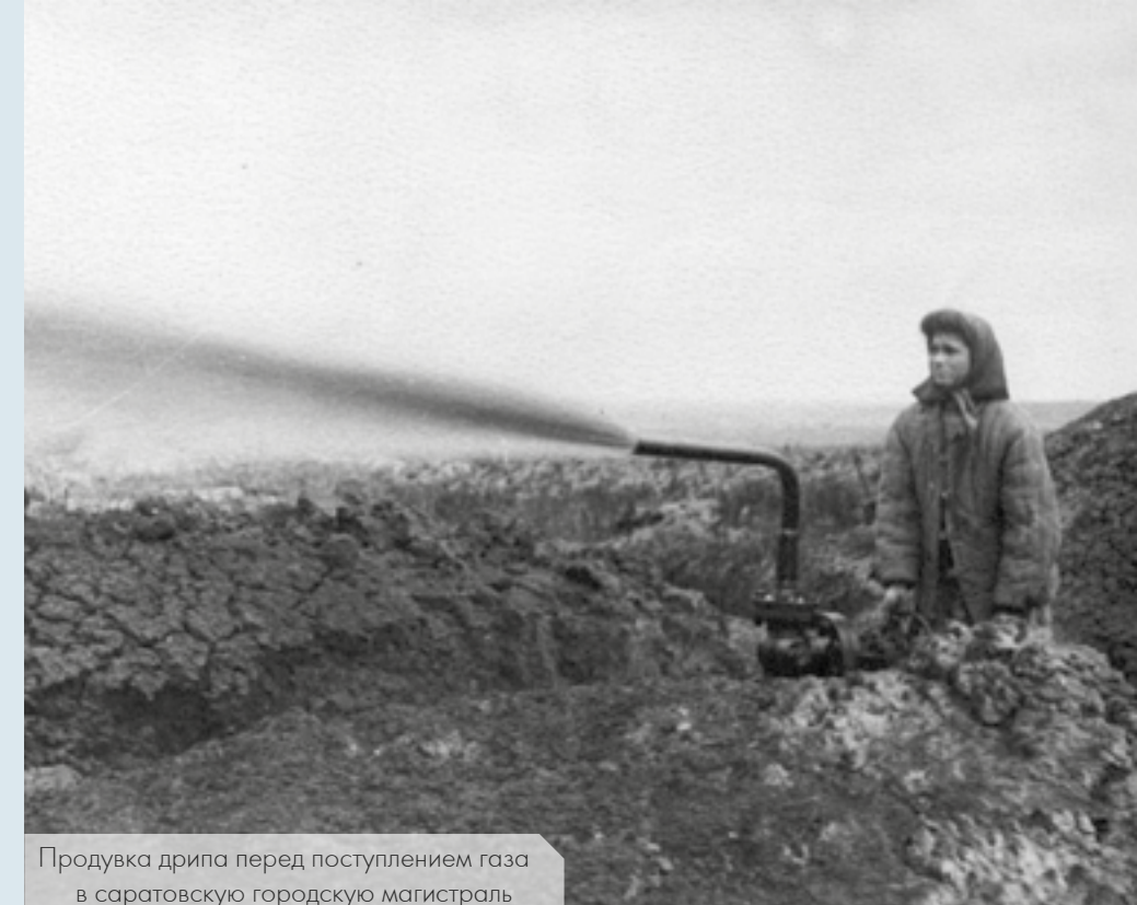
Подготовка к опробованию газопровода Елшанка–Саратовская ГРЭС
