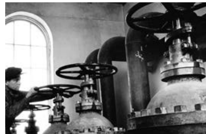
Пуско-наладочные работы на Кирсановской компрессорной станции № 3. 1946
