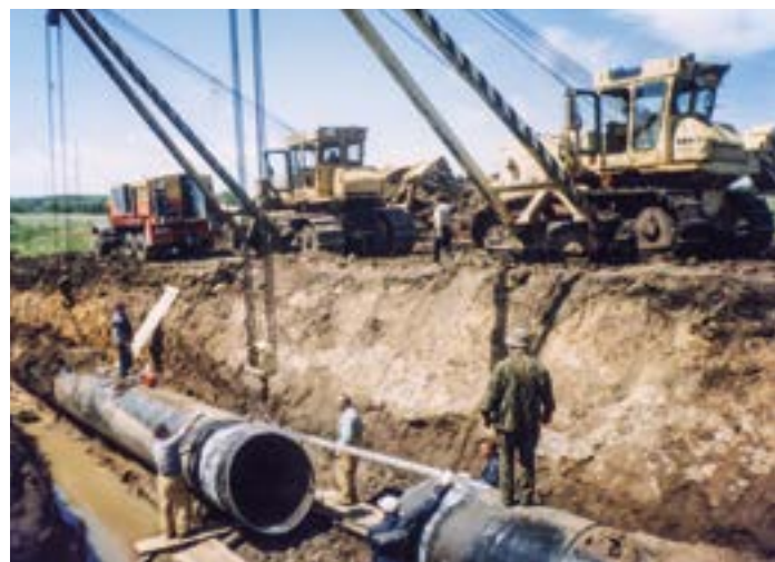
Ремонт участка уренгойского газотранспортного коридора на территории Петровского ЛПУМГ. Начало 2000-х
