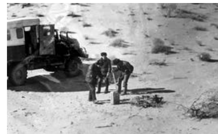
Разбивка участка газопровода САЦ I
