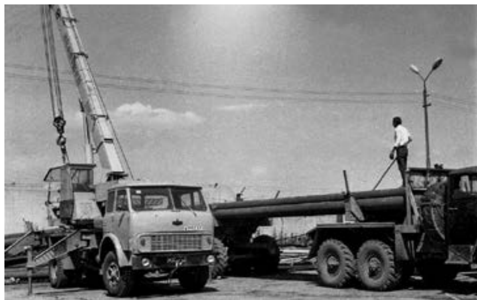
Подготовка транспортной техники к ремонтным работам. 1987
