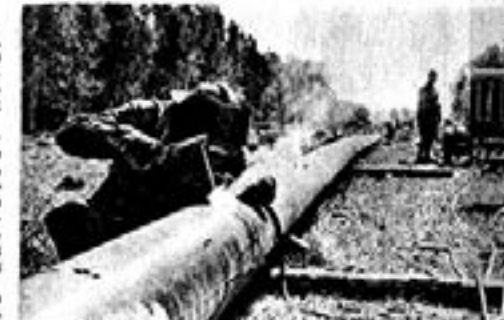
По этим трубам будет проходить газ. Трубы (длиной в 12 метров каждая) свариваются при помощи электрических аппаратов.
