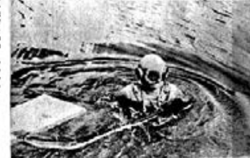
Трасса газопровода проходит через реку Панду. Старшина 2-й станции Н. Грудков спускает под воду для осмотра траншею, в которую будут уложены трубы.
