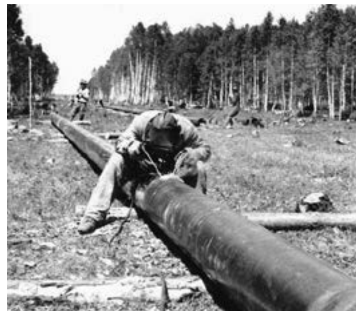
Сварка труб на участке газопровода Саратов – Москва в Коломенском районе Московской области. 1945
