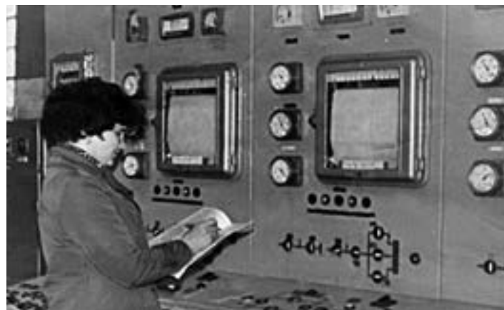
Главный щит управления. Мещерское ЛПУМГ. 1981
