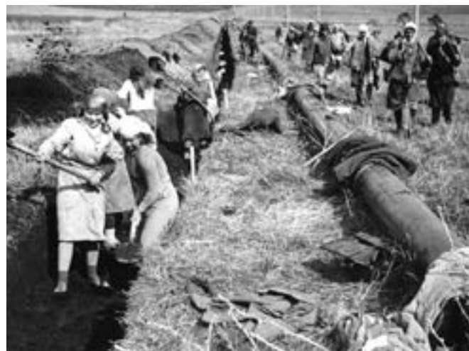
Рытьё траншеи для газопровода Саратов–Москва. 1945
