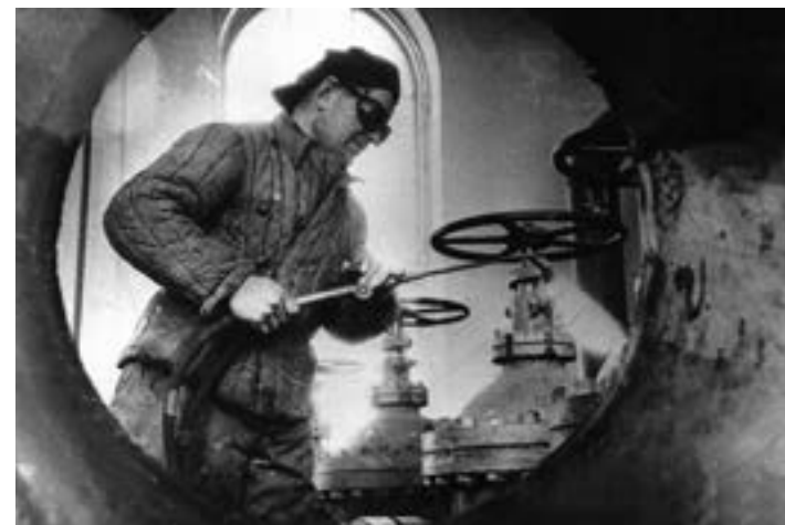
Сварочные работы на одной из газораспределительных станций газопровода Саратов – Москва. 1944
