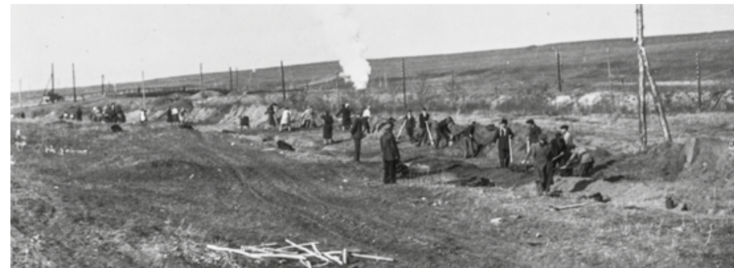
Рытьё траншеи для газопровода Елшанка – Саратовская ГРЭС на территории Красноармейского района
