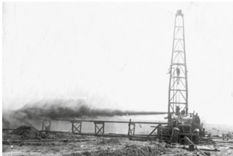
Продувка одной из скважин в Елшанке
