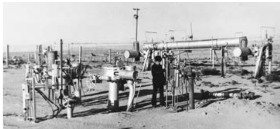
Проверка дистанционного управления кранами на компрессорной станции в Казахстане
