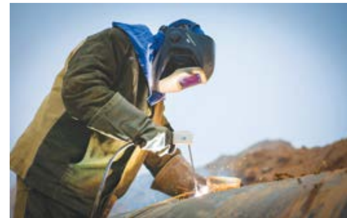
Огневые работы в Петровском ЛПУМГ. 2018
