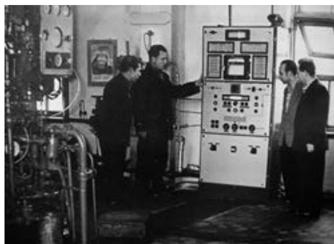
Пневмоэлектрическая система автоматического управления на Кологривовской КС
