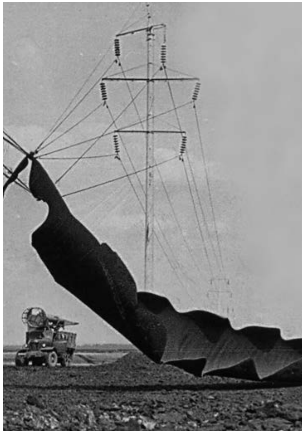
Разрыв первой нитки газопровода Средняя Азия – Центр на участке Петровск – Мещерское. 1967
