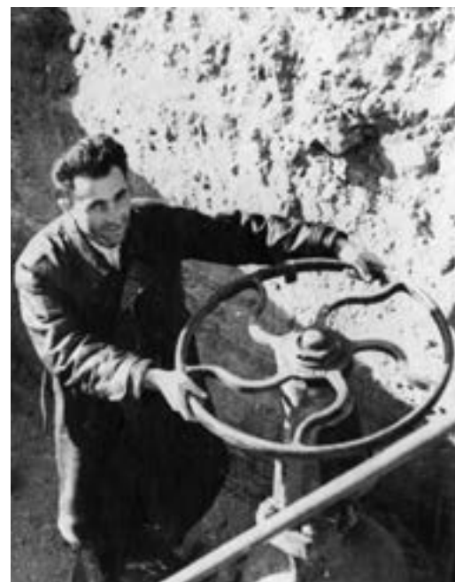
Пробный пуск газа на СарГРЭС. Открытие задвижки
