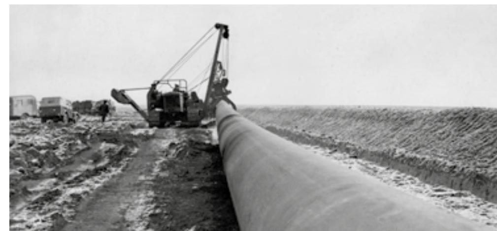
Укладка трубы газопровода САЦ на окраине посёлка Мокроус. 1968
