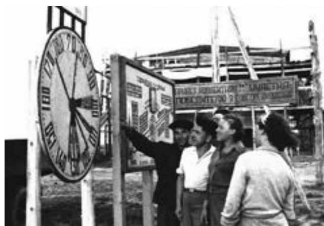
Рабочие 2-го участка 6-го района строительства газопровода «Саратов – Москва» у доски показателей. Московская область. 1945
