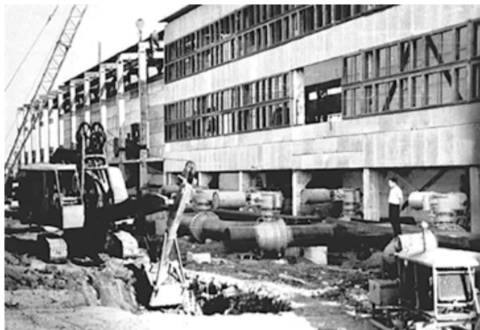
Башмаковская компрессорная станция была определена как узловая на участке от г. Петровска Саратовской области до г. Воскресенска в Подмосковье. 1964
