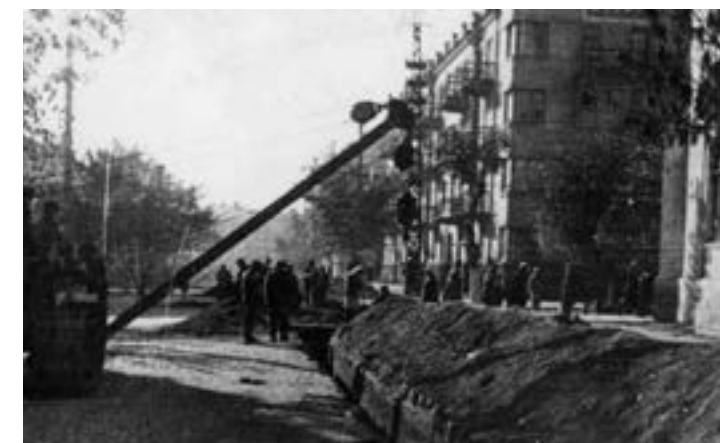
Подготовка и укладка труб на улице Некрасова
