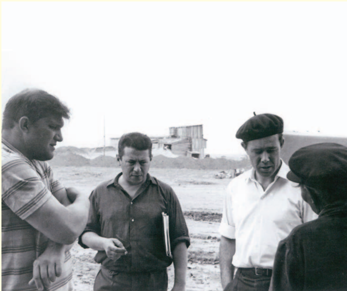
Компрессорная станция «Индерборская» газопровода «Средняя Азия – Центр». Ветераны строительства и эксплуатации газопровода (слева направо): Д. С. Онисин, Э. Г. Банаян и Ю. Д. Лебедев-Цветков. 1968 год.
