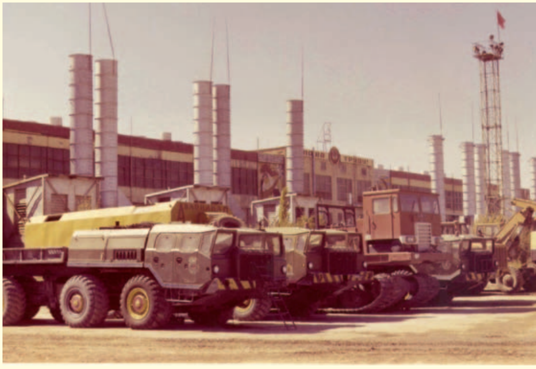
Аварийно-восстановительный поезд. КС «Хива»
