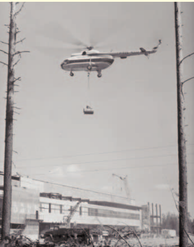
На строительстве газопровода «Средняя Азия – Центр» использовалась различного рода техника
