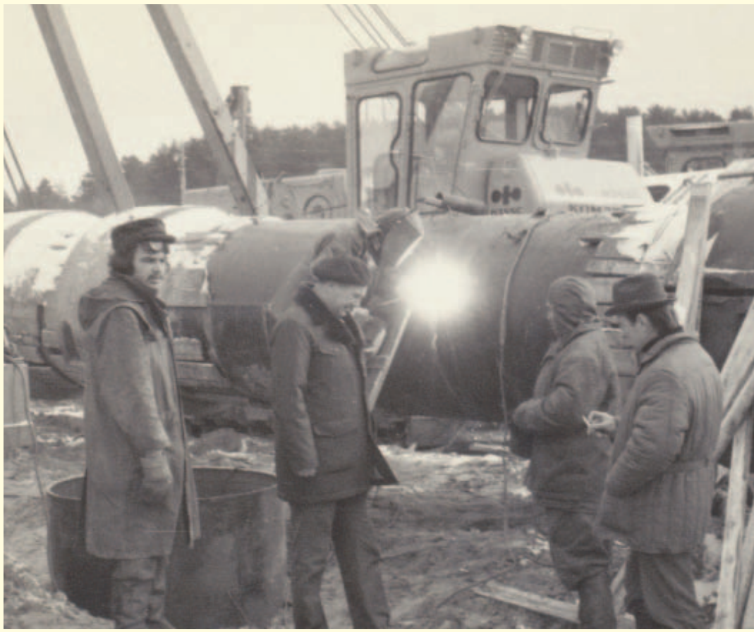
Ремонтные работы на газопроводе «САЦ». 1980-е годы
