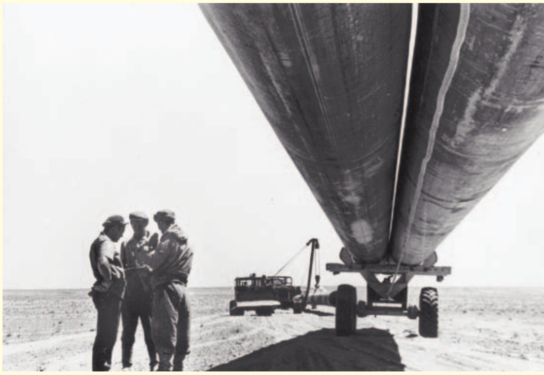
Строительство газопровода «САЦ-III»
