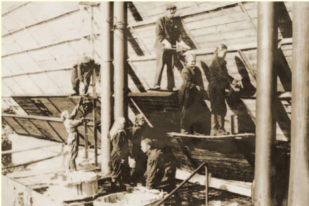
Строительство компрессорной станции в Петровске. 1967 г.
