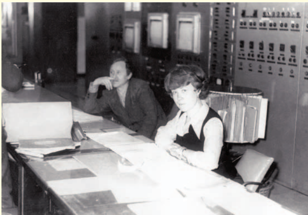
Главный щит управления. 1973 г.
