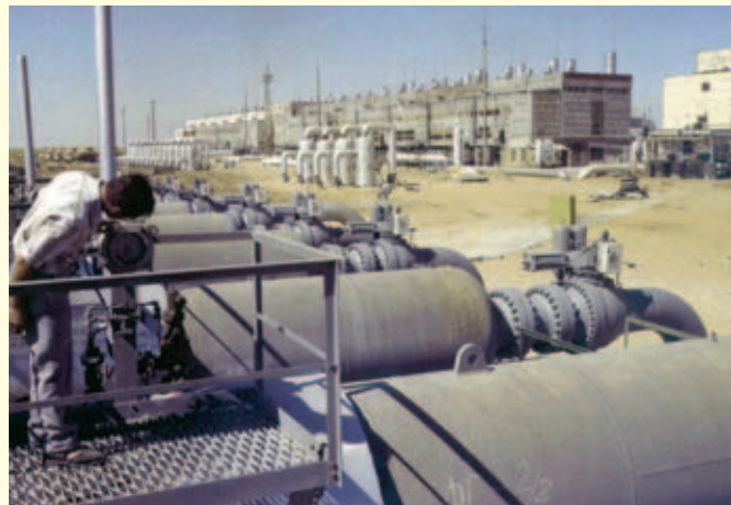
Фильтры-сепараторы. КС «Хива»
