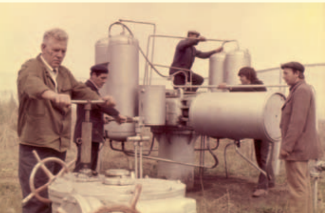
Крановая площадка Приволжского ЛПУ МГ. 1979 г.
