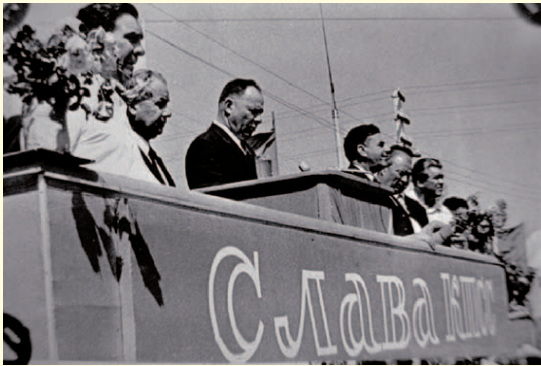
Торжественный митинг в Елшанке, посвященный досрочному завершению строительства участка Кунград – Петровск газопровода «САЦ». На трибуне министр нефтяной и газовой промышленности А. К. Кортунов. Июль 1967 г.
