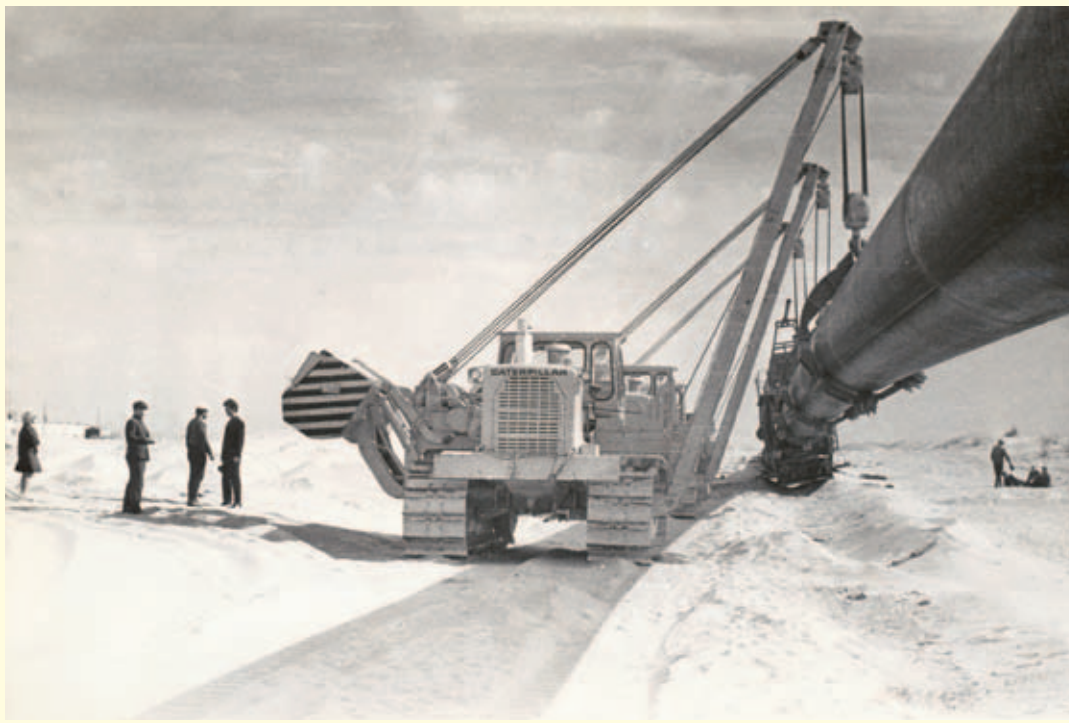
При строительстве газопровода «САЦ» использовались новые методы укладки труб в условиях барханных песков
