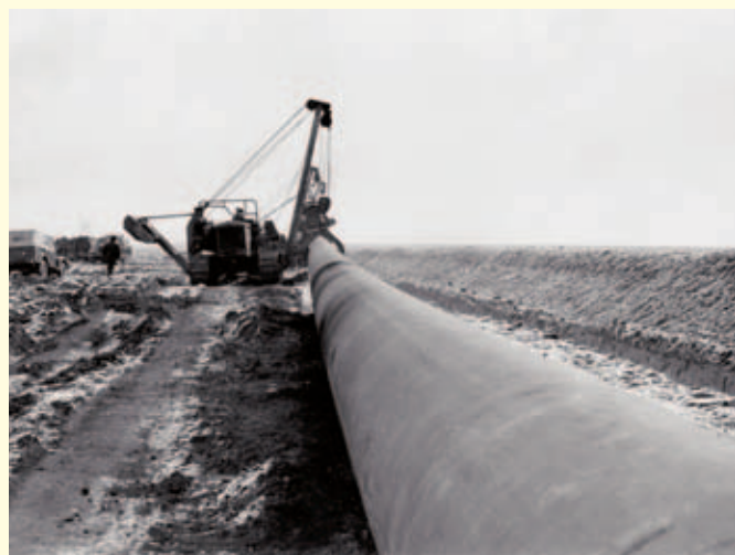
Укладка трубы газопровода «САЦ» на окраине поселка Мокроус. 1968 г.
