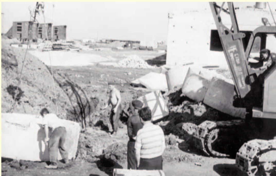
Строительство КС в Башмаково. 1967 г.
