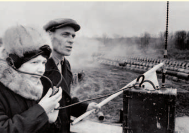
Прокладка газопровода по дну Волги
