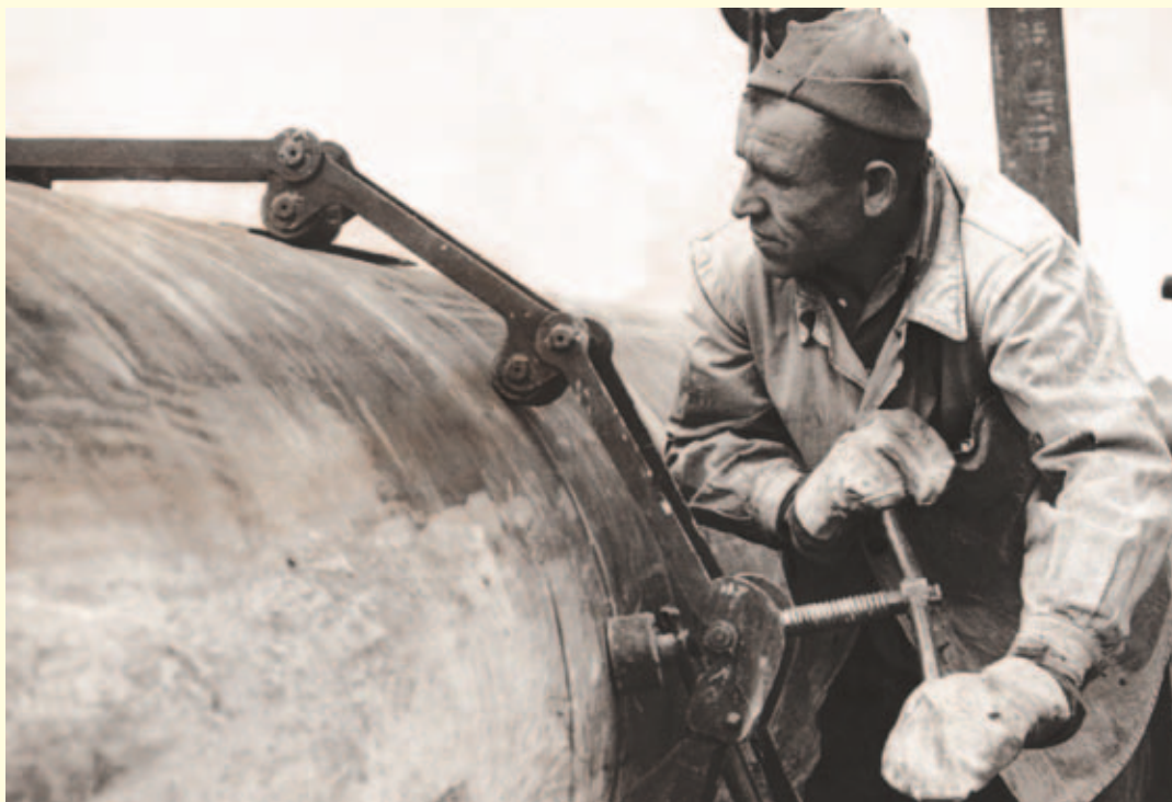
Слесарь-монтажник А.П. Ильин. На стыковке труб через Волгу. 1966 г.
