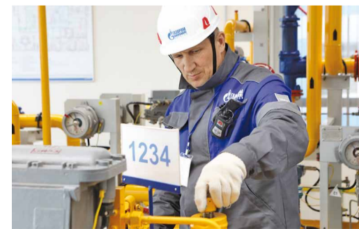
Настройка регулятора давления газа
