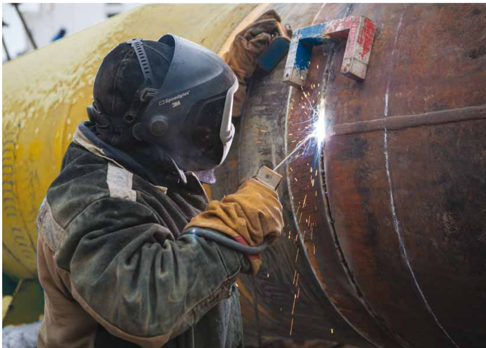
Огневые работы на газопроводе «Сторожевка-Петровск»
