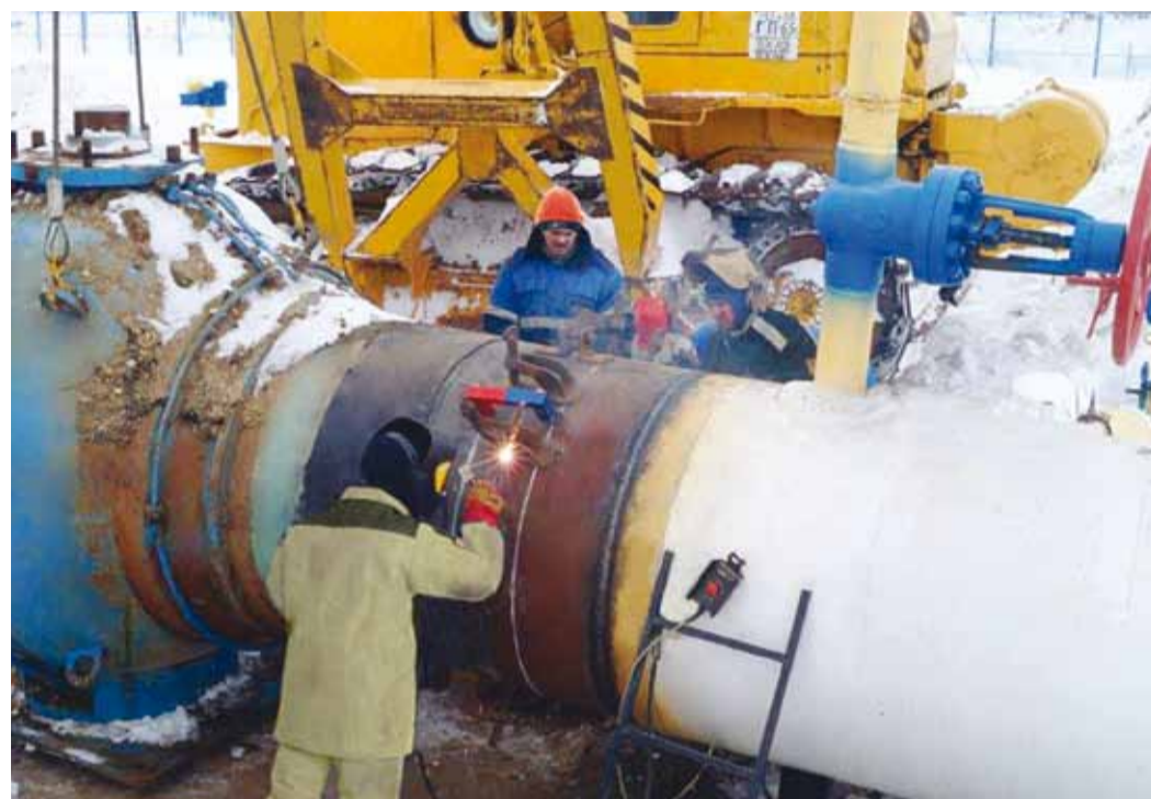
Подготовительные работы перед монтажом крана
