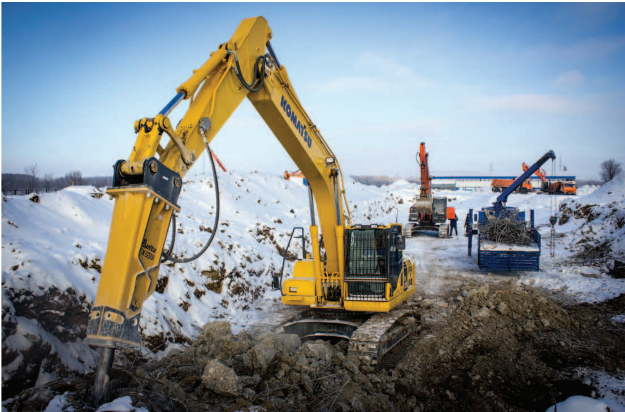
Демонтаж фундамента ЭГПА №5 компрессорного цеха №4
