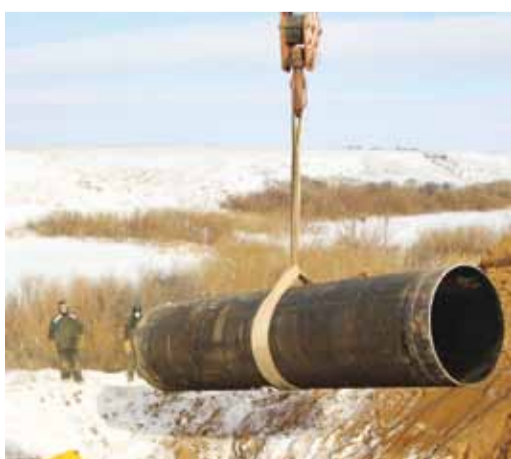
Контроль работ на трассе
