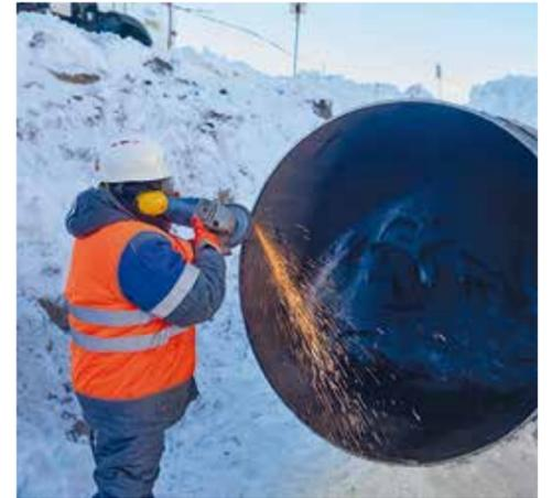
Подготовка кромки трубы
