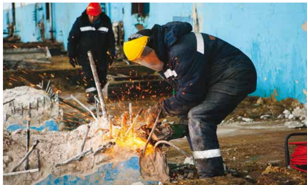
Демонтаж бетонных подставок в галерее центробежных нагнетателей
