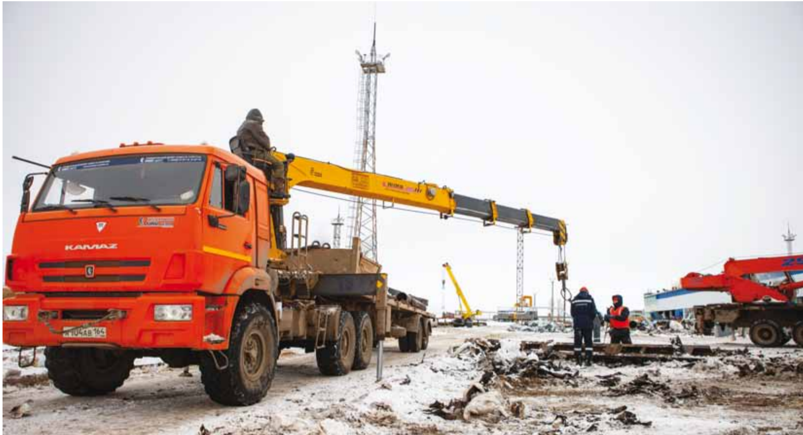
Выполняется вывоз элементов конструкции цеха на площадку временного хранения
