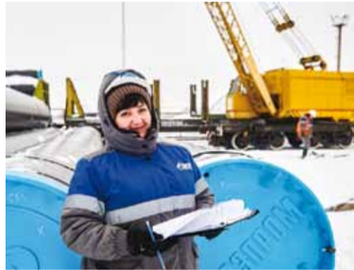
Каждая труба проходит строгий входной контроль
