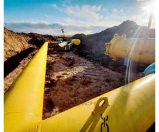
Монтаж мобильной камеры для проведения ВТД
