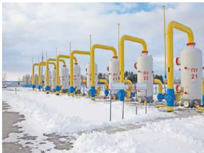
Обновленные пылеуловители после покраски
