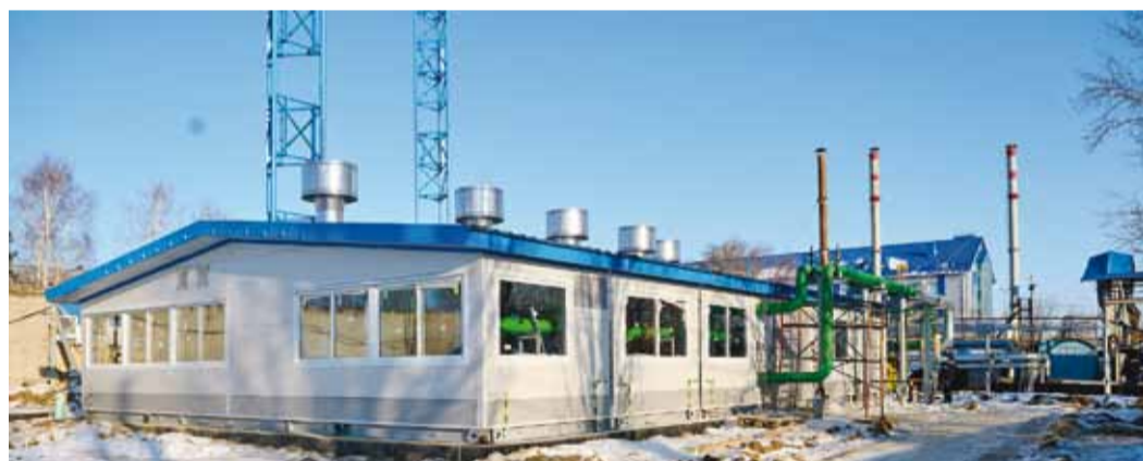
Новая котельная УМТСиК
