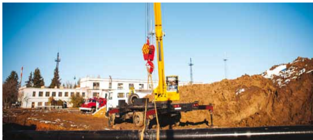
Надежность работы технологических трубопроводов после комплексного ремонта существенно повысилась
