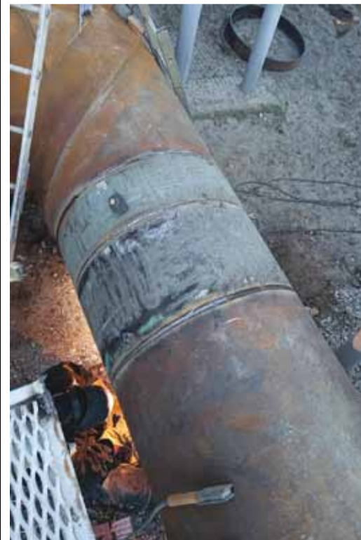
Ремонт участка трубопровода диаметром 1020 мм
