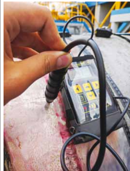
Измерение глубины дефекта
