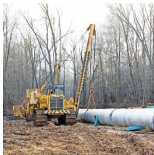
Плеть нового газопровода
