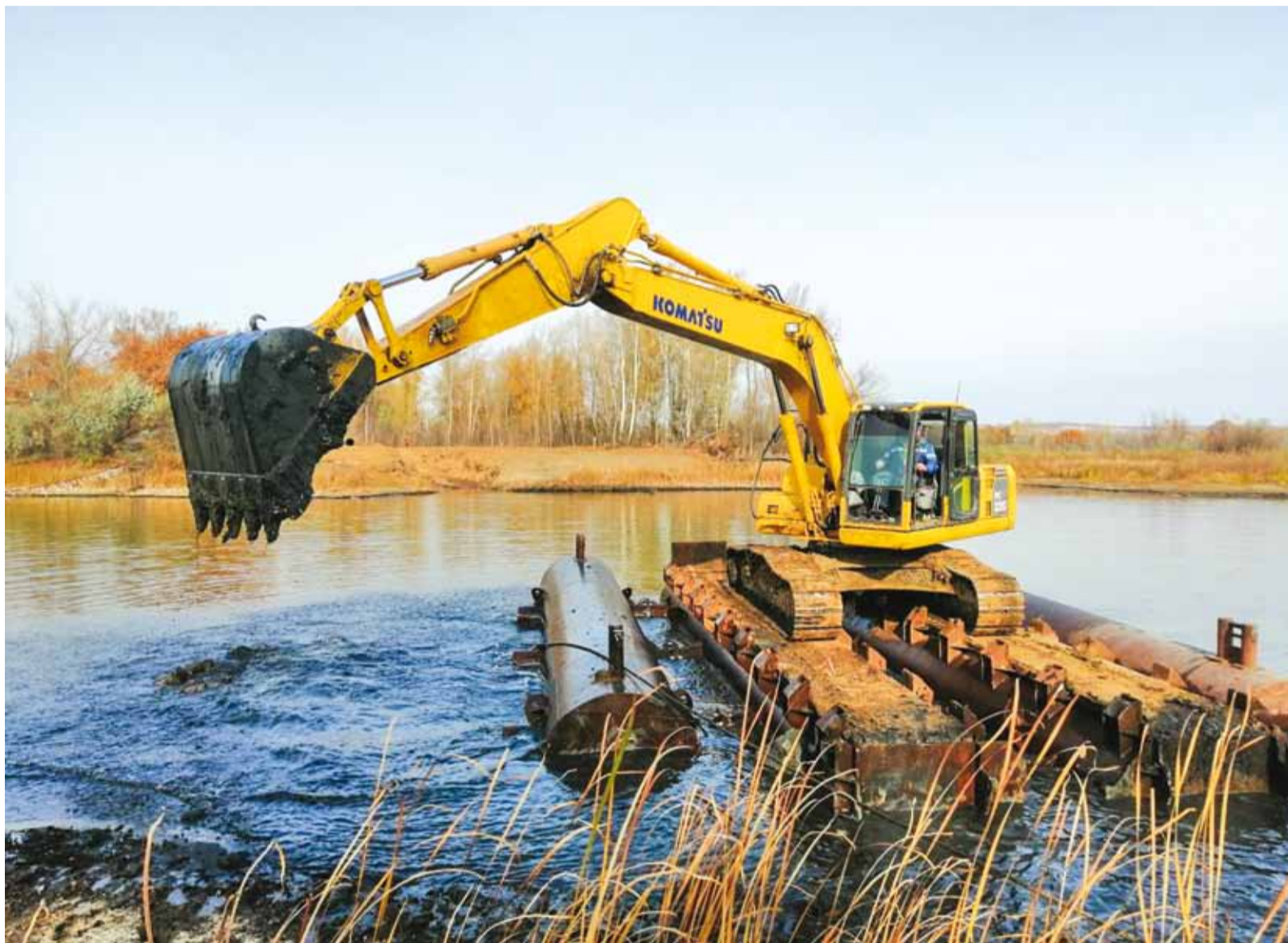
Работа экскаватора в русле Волги
