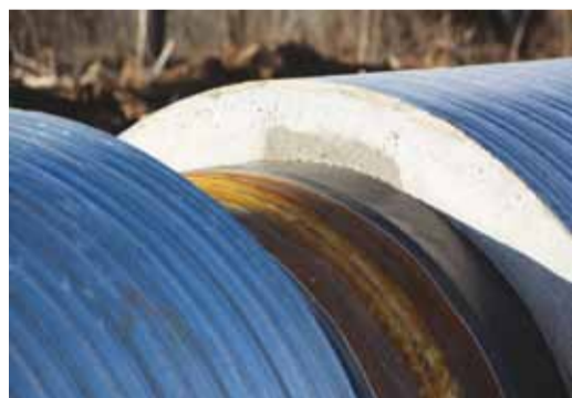
Новая труба с бетонным покрытием
