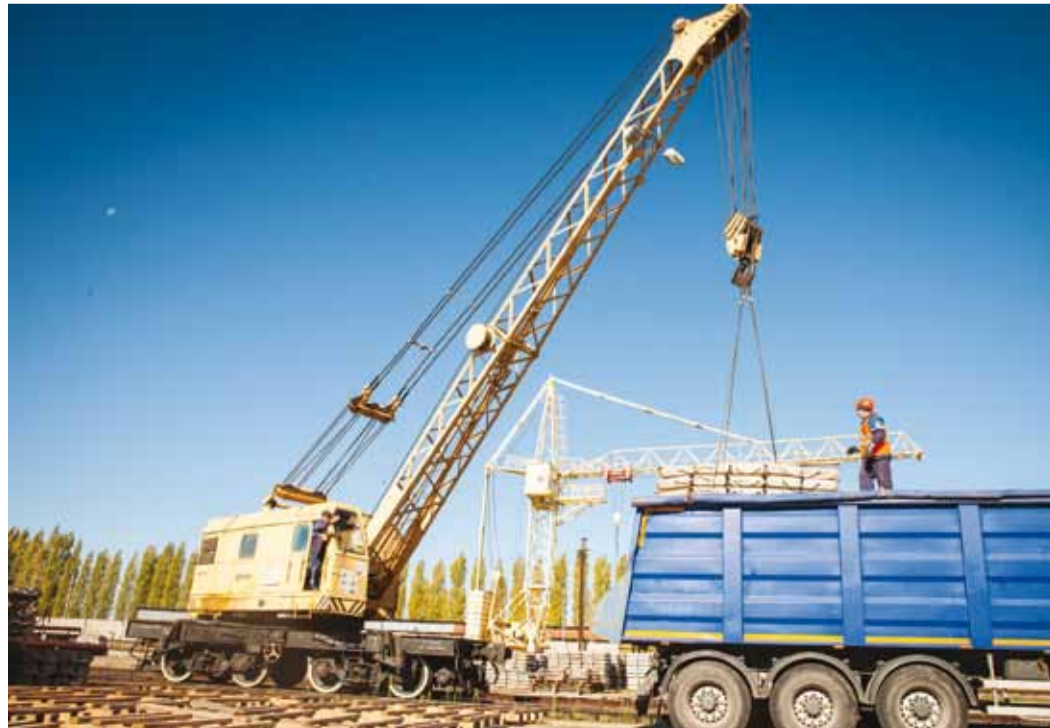
Очередная партия гибких бетонных матов отправляется к месту проведения работ
