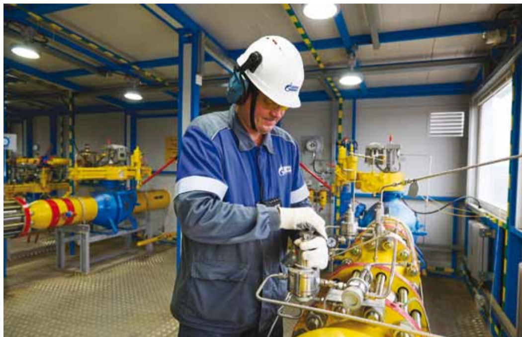
Работы на ГРС г. Балаково
