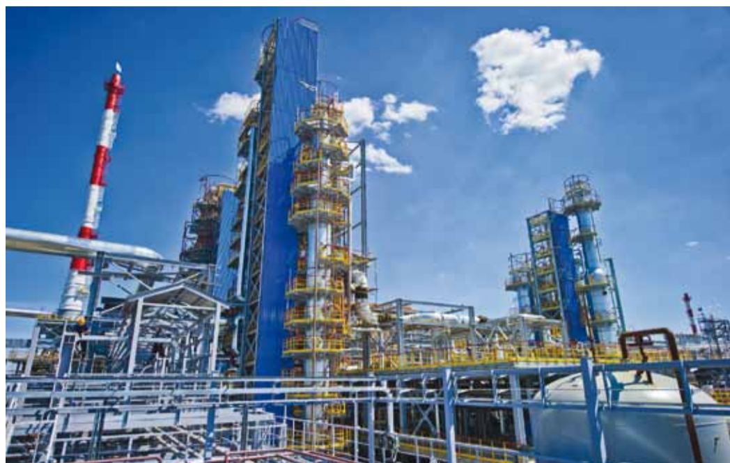
Нефтеперерабатывающий завод. Установка АВТ-6
