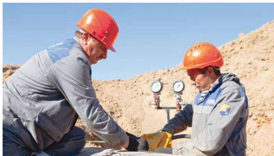
Трубопроводчики линейные 5 разряда Николай Бобров (слева) и Сергей Базан устанавливают внутреннее герметизирующее устройство
