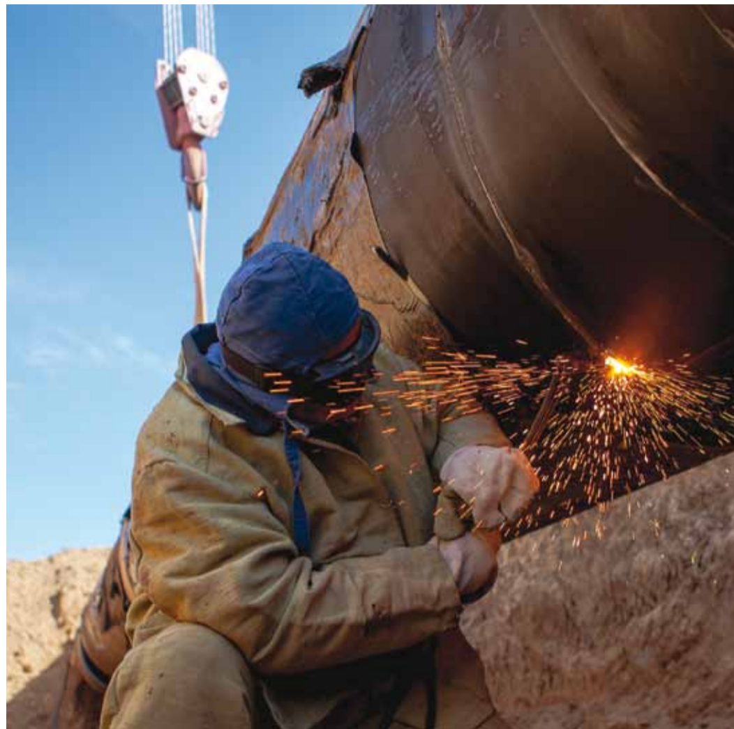
Электрогазосварщик УАВР Сергей Александрин производит вырезку дефектного участка газопровода
