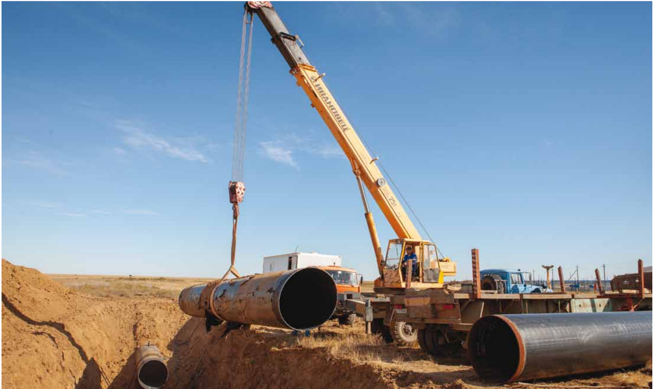
Ремонтные работы на магистральном газопроводе САЦ-5
