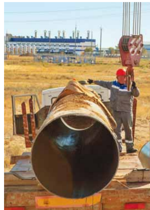
Вывоз демонтированной трубы на склад
