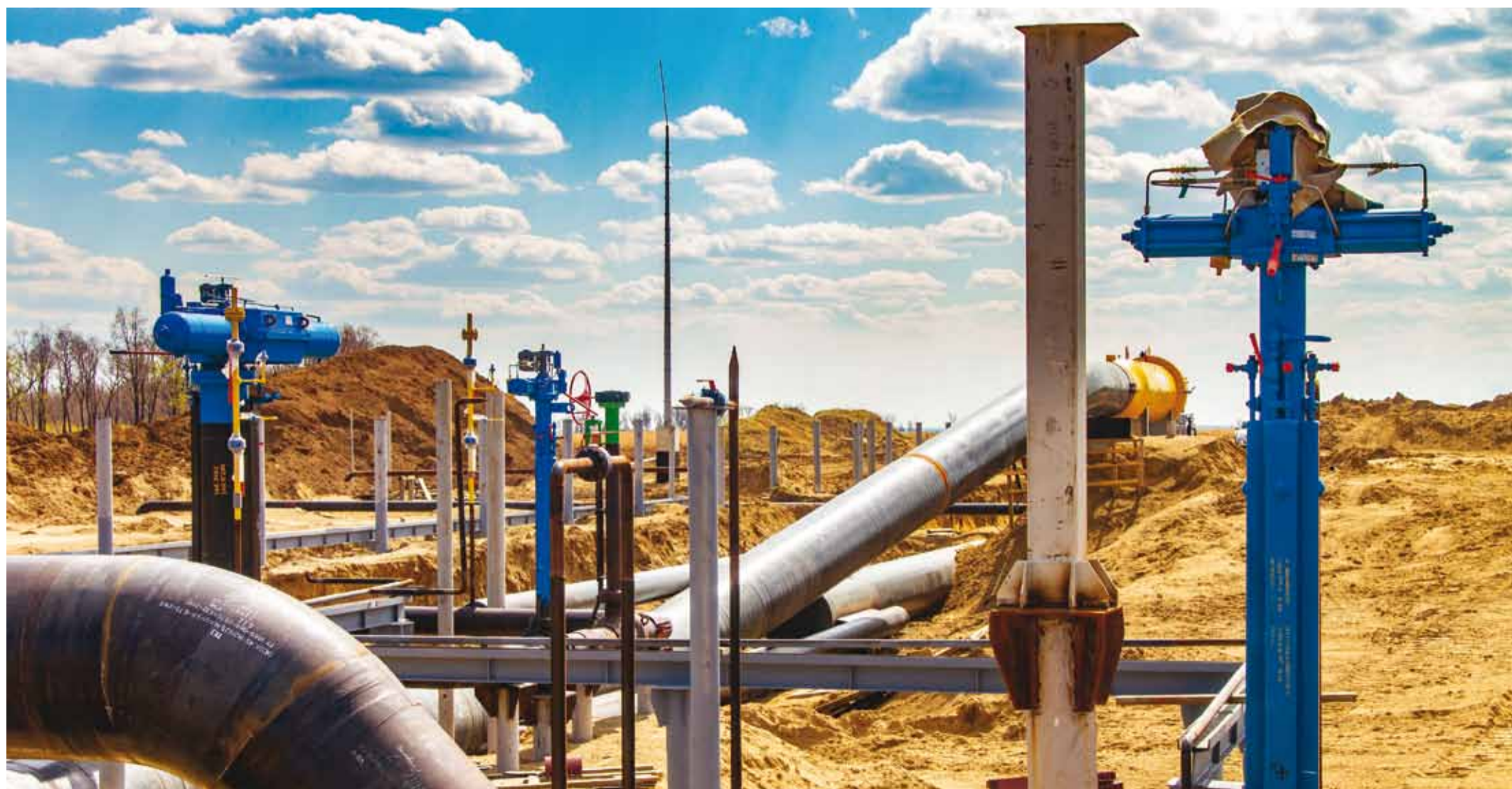
Строительство объектов газопровода «Сила Сибири»
