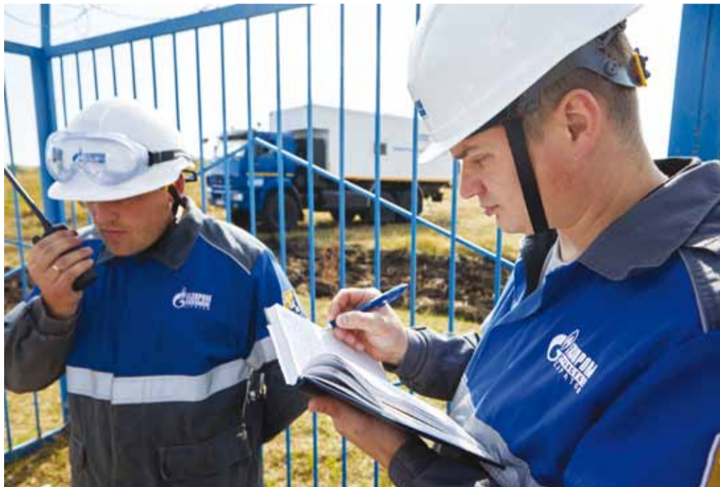
Фиксация замечаний на крановом узле линейно-эксплуатационной службы
