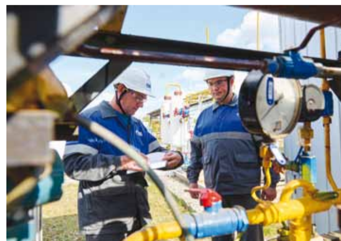
Контроль работы оборудования ГРС
