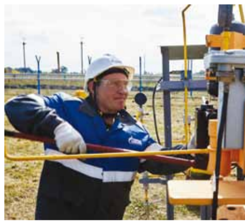
Набивка крана в зоне ответственности ГКС филиала
