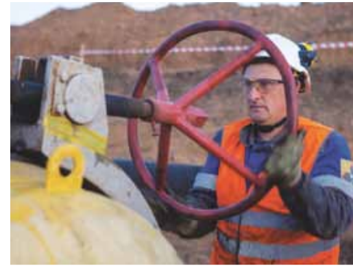
Завершающий этап работ
