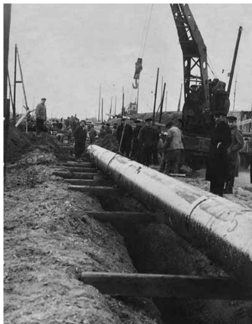
Газопровод «Елианка - Саратов»
