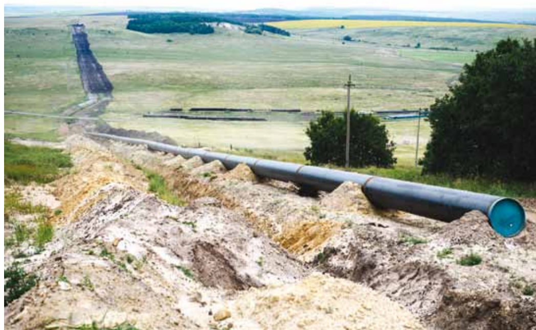
Более трети труб тринадцатикилометрового участка уже сварено в нитку
