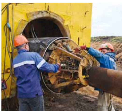
Запасовка внутреннего центратора
