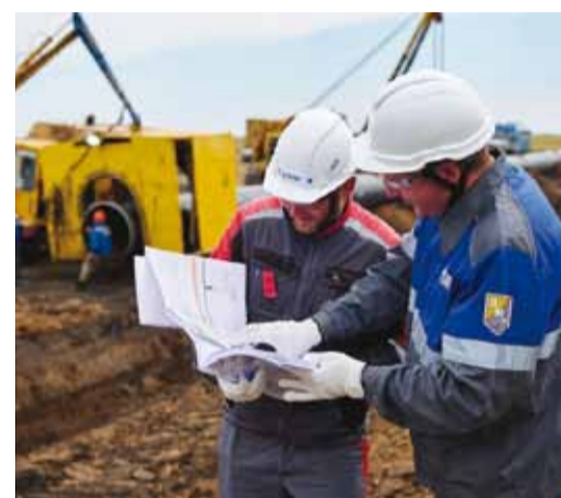
Обсуждение хода капремонта
