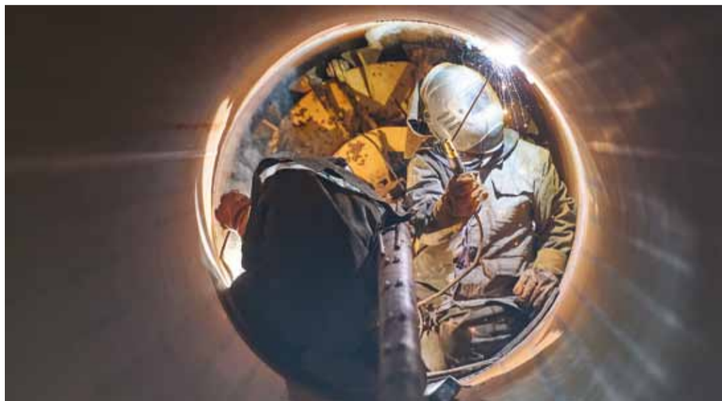
Выполнение подварочного шва
