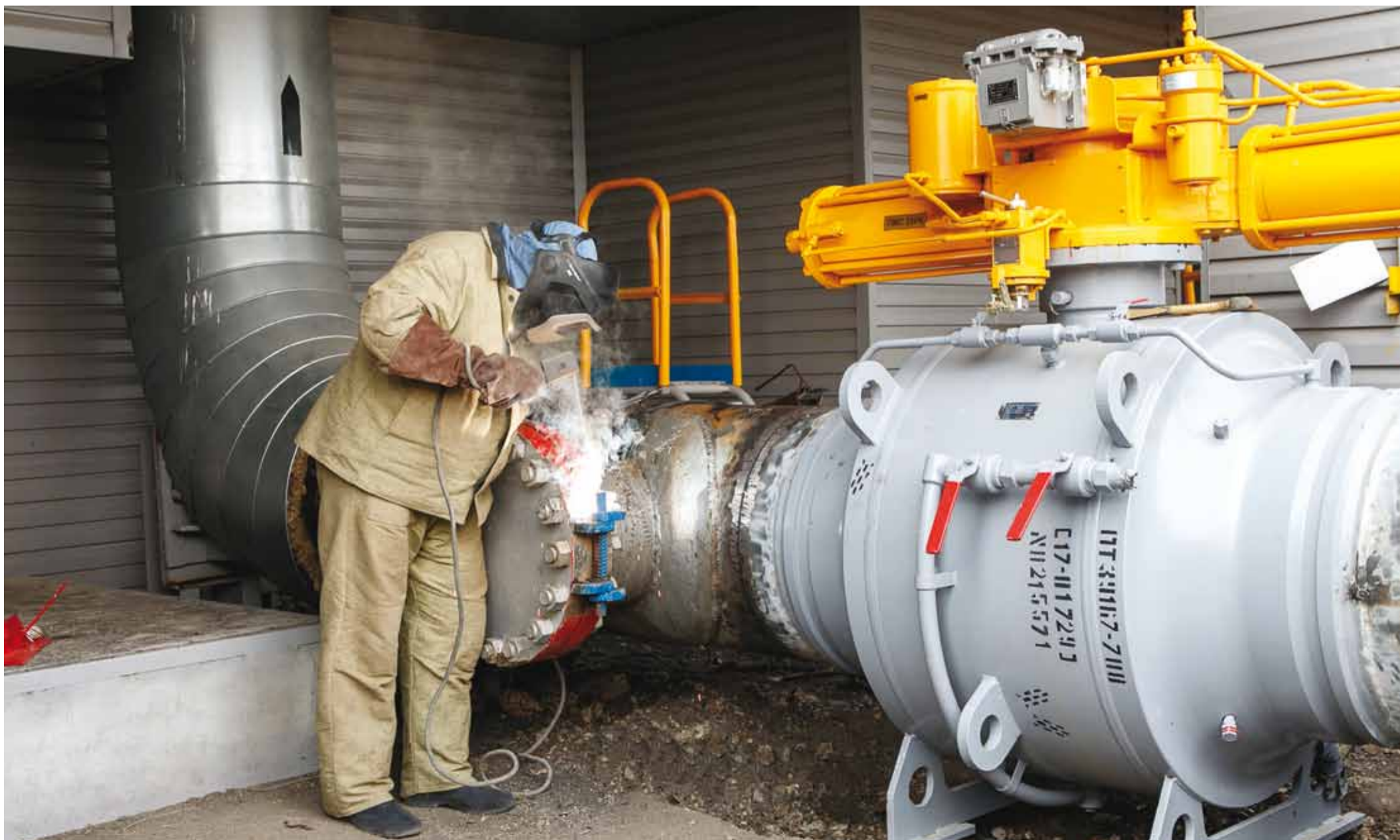
Проводятся сварочно-монтажные работы
