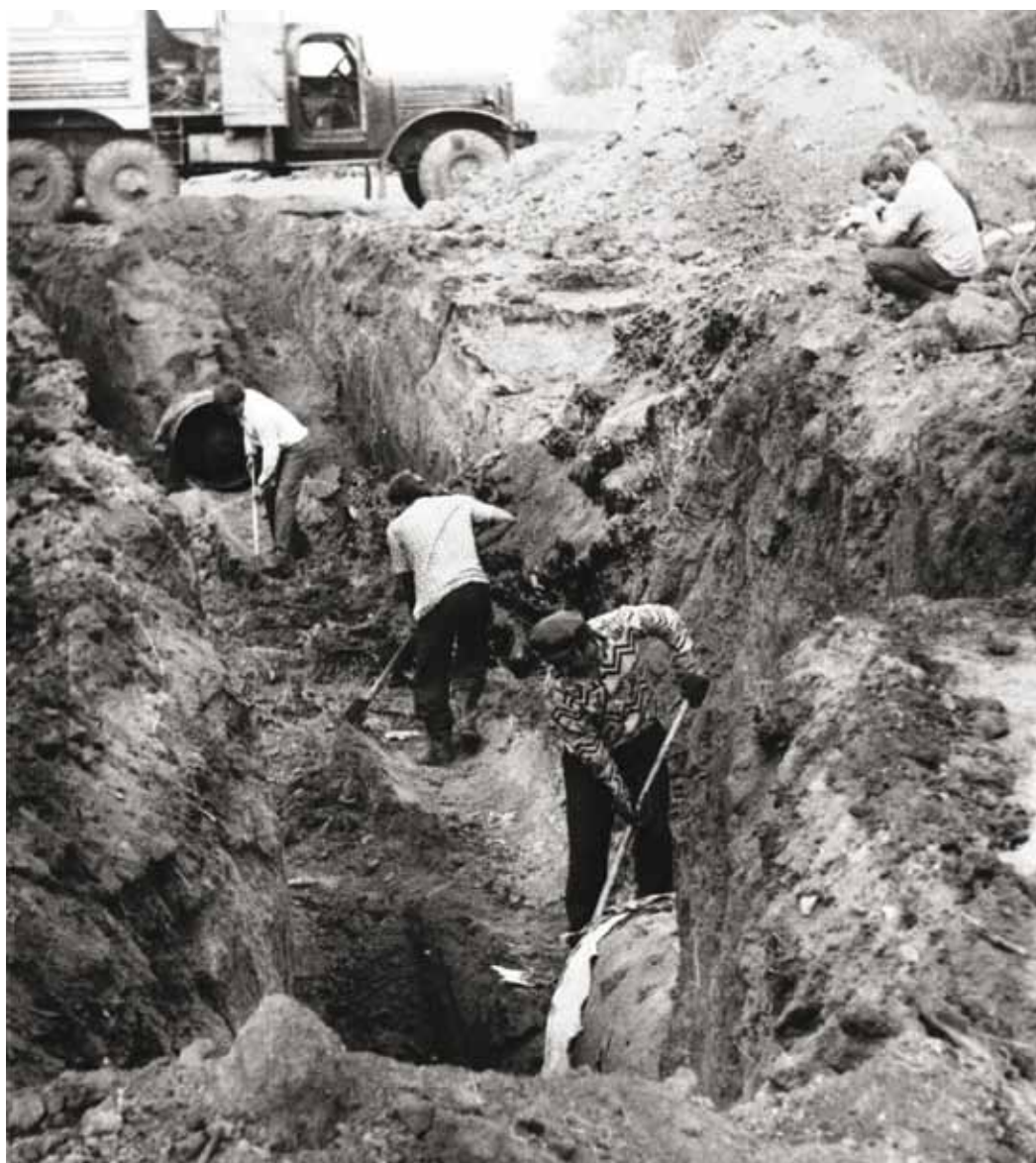
Проводятся земляные работы на газопроводе «Мокроус – Самара – Тольятти»
