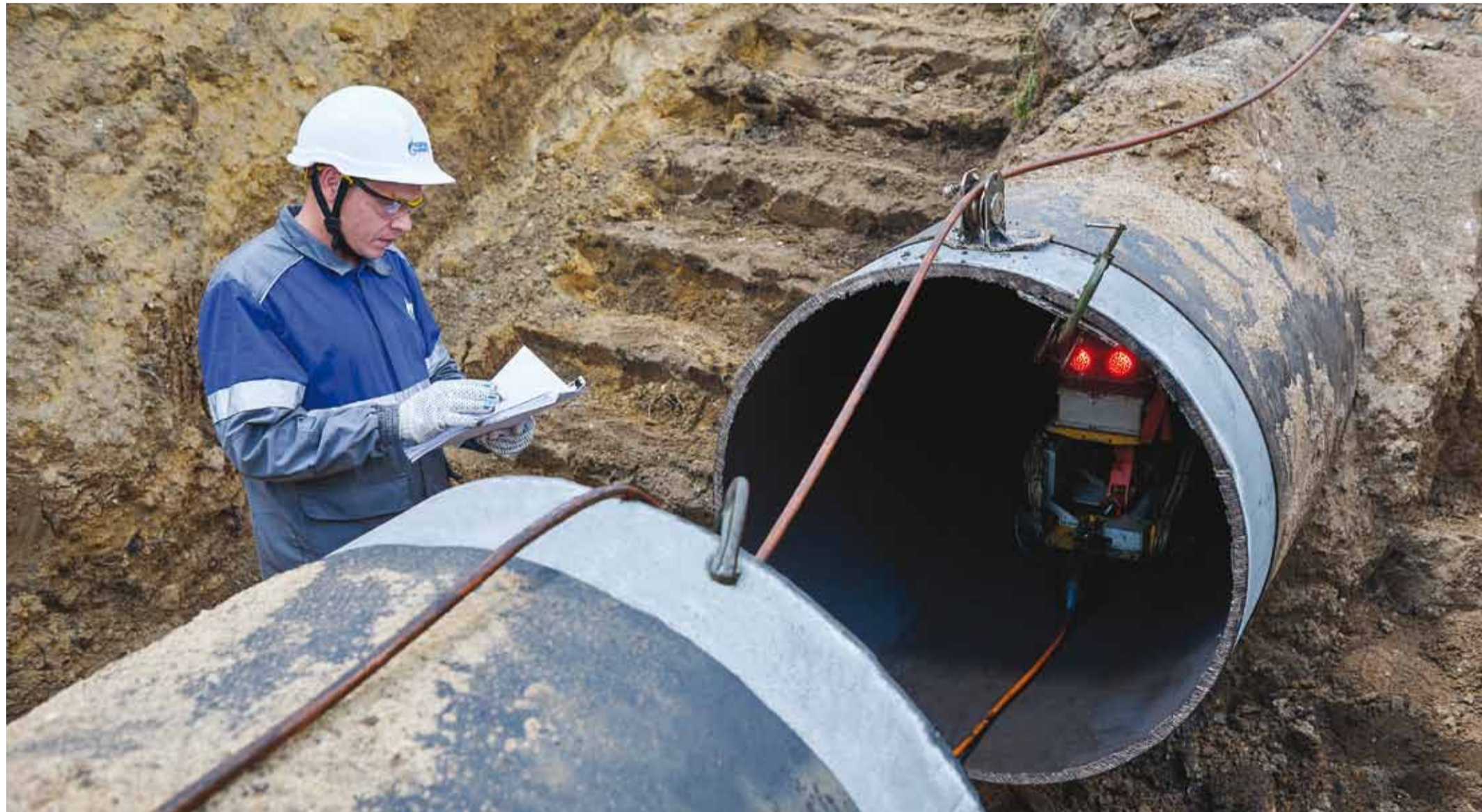
Начальник газокомпрессорной службы Екатериновского ЛПУМГ Дмитрий Синев контролирует процесс проведения работ
