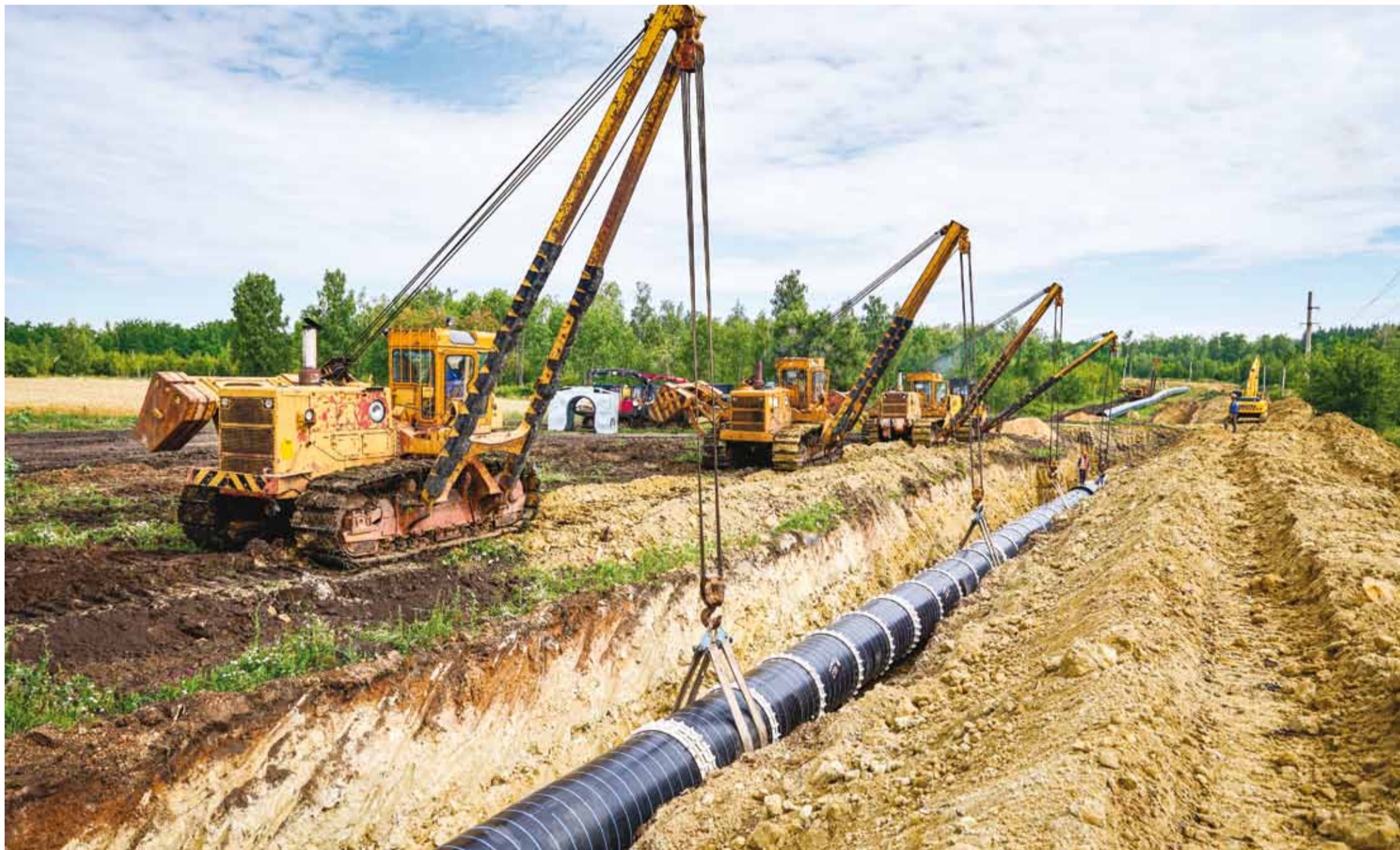
Строительство газопровода Починки – Анапа
