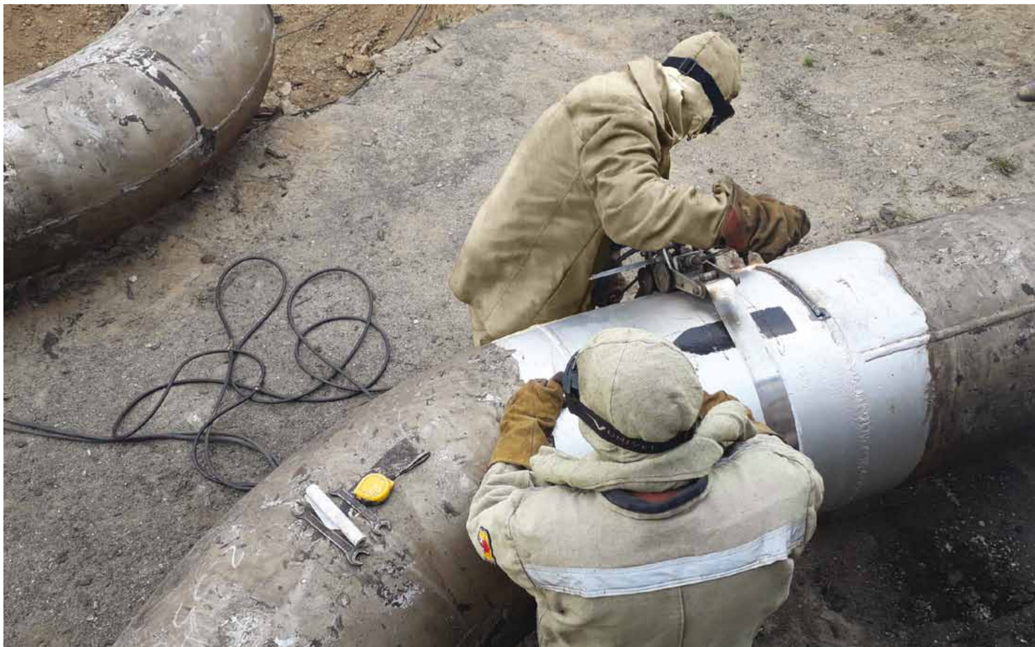
Производится подключение трубопроводной обвязки ЦБН ГПА №5 к выходному шлейфу второй группы КЦ №1 КС Алтай
