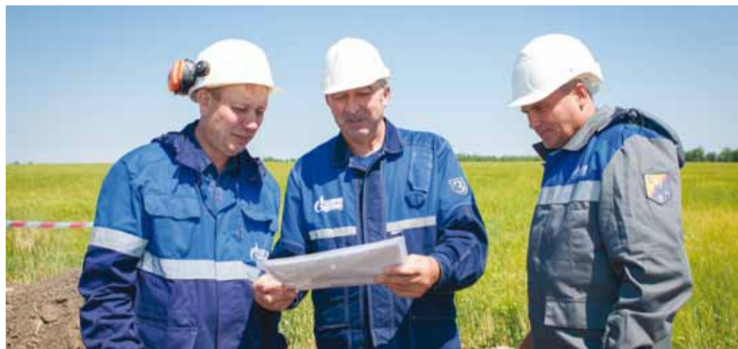
Последние уточнения - непосредственно на месте разрыва газопровода
