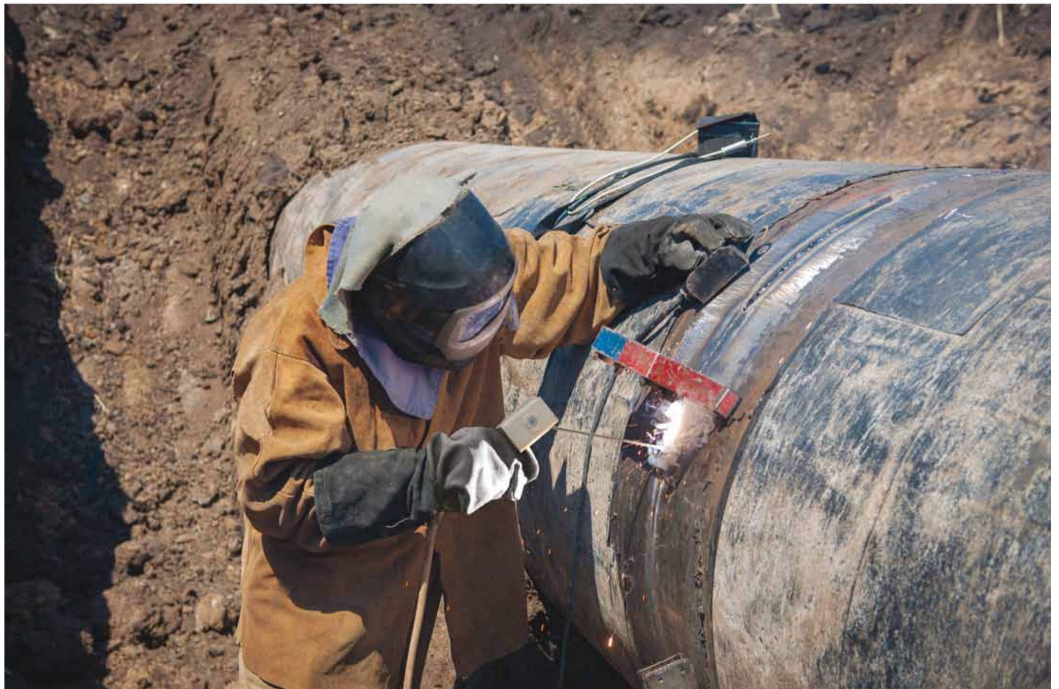
Аварийно-восстановительные работы на месте условной аварии на газопровode «Петровск - Новопсков»
