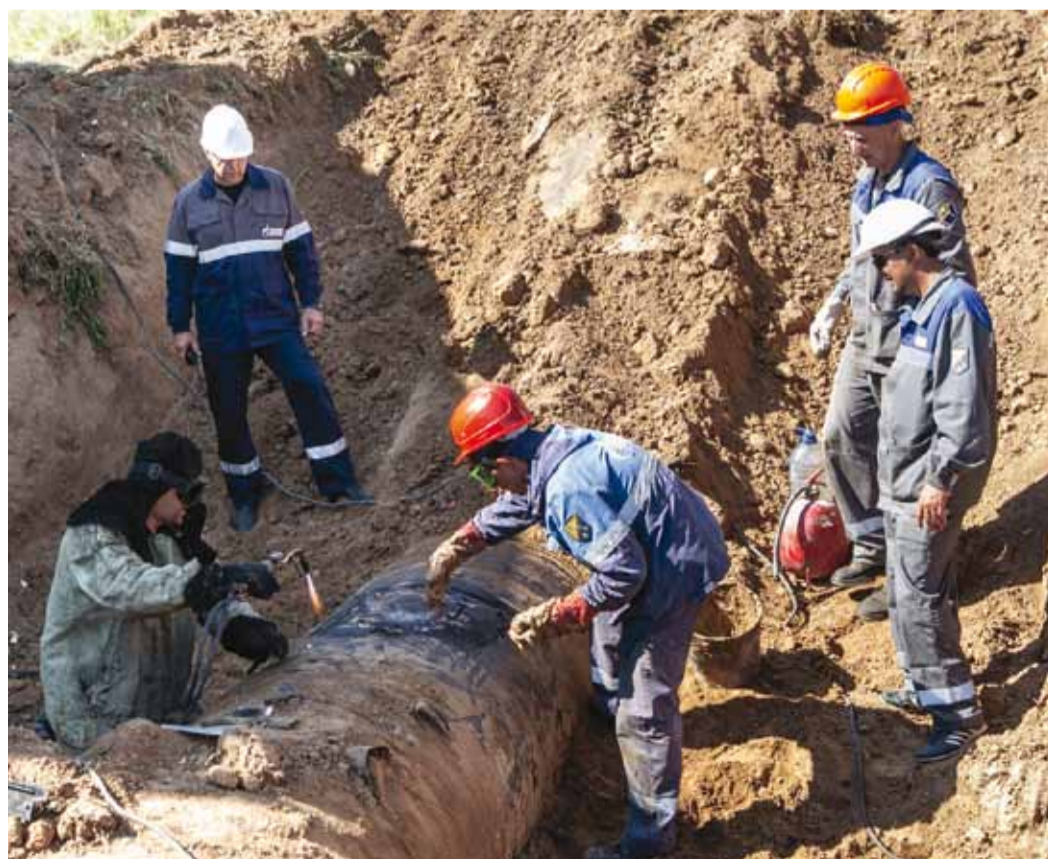
Проводится вырезка технологических отверстий для установки заглушек
