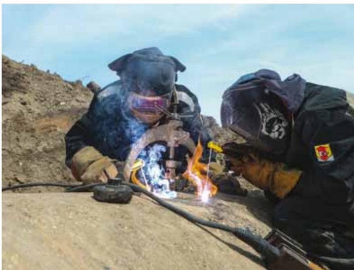
Сварка технологического отверстия под заплату
