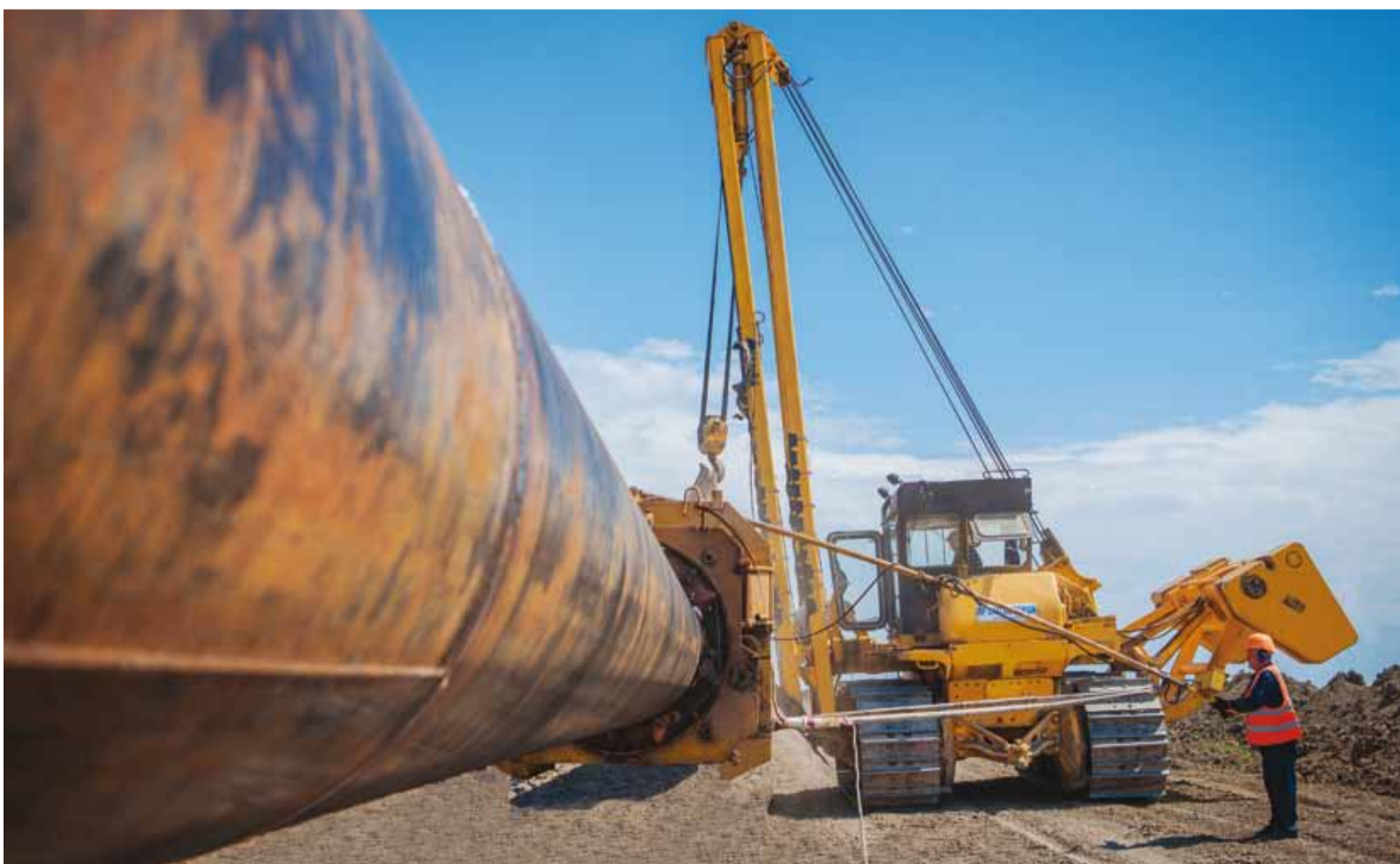
Производится очистка трубы от изоляции
