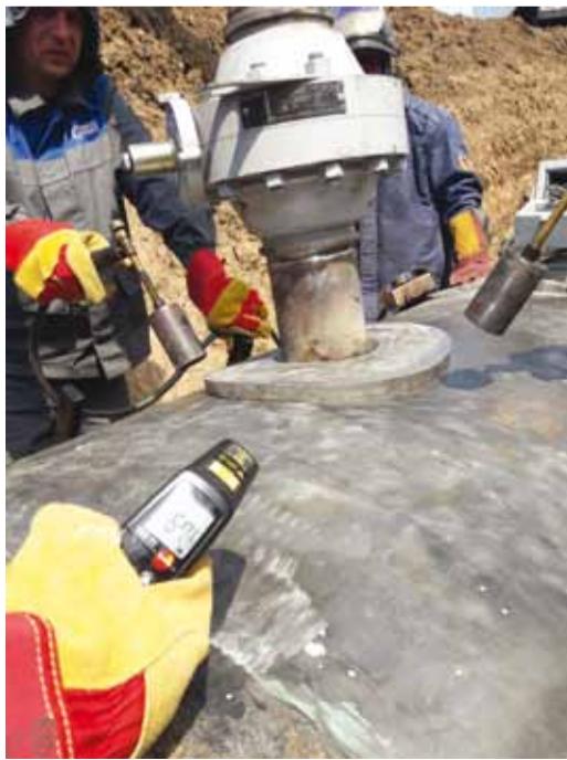
Производится прогрев трубы
