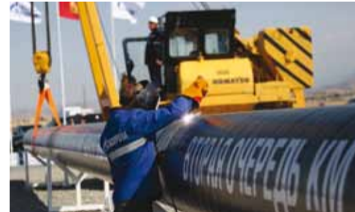
Сварка первого стыка
