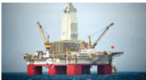
Бурение разведочной скважины на Южно-Киринском месторождении
