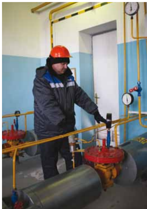
После реконструкции завершены пуско-наладочные работы на трех бывших бесхозяйных газораспределительных станциях, предназначенных для газоснабжения потребителей Аткарского и Лысогорского районов
