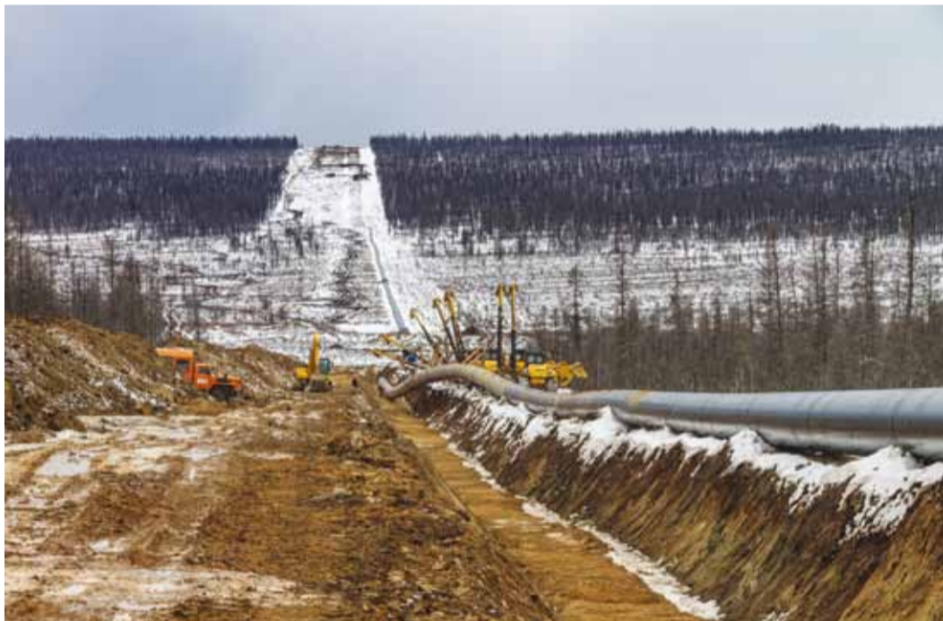
Строительство газопровода «Сила Сибири»
