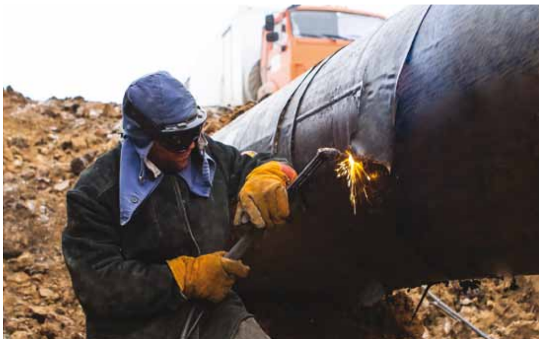
Значительные объемы ремонтных и диагностических работ на объектах магистральных газопроводов выполняются в настоящее время собственными силами
