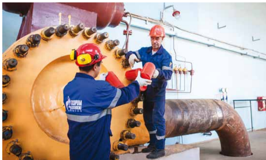
Завершающие работы по сборке нагнетателя после гидроиспытаний
