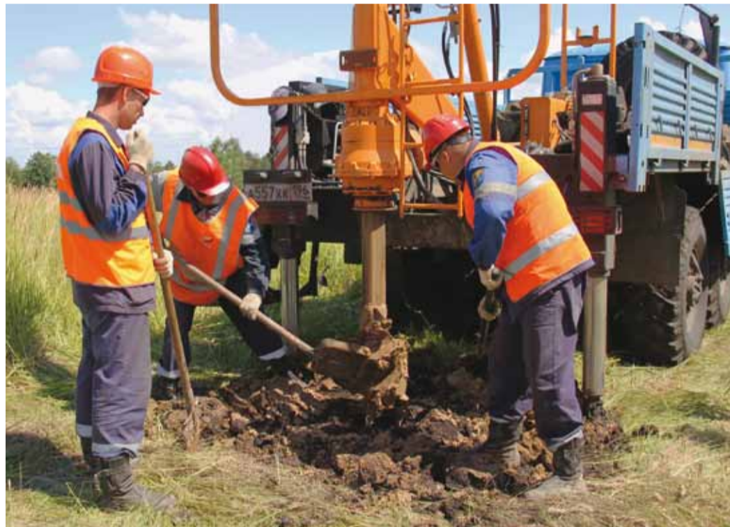
Работы по бурению скважины под электроды анодного заземления
