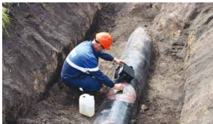
Проведение ультразвукового контроля технологического отверстия
