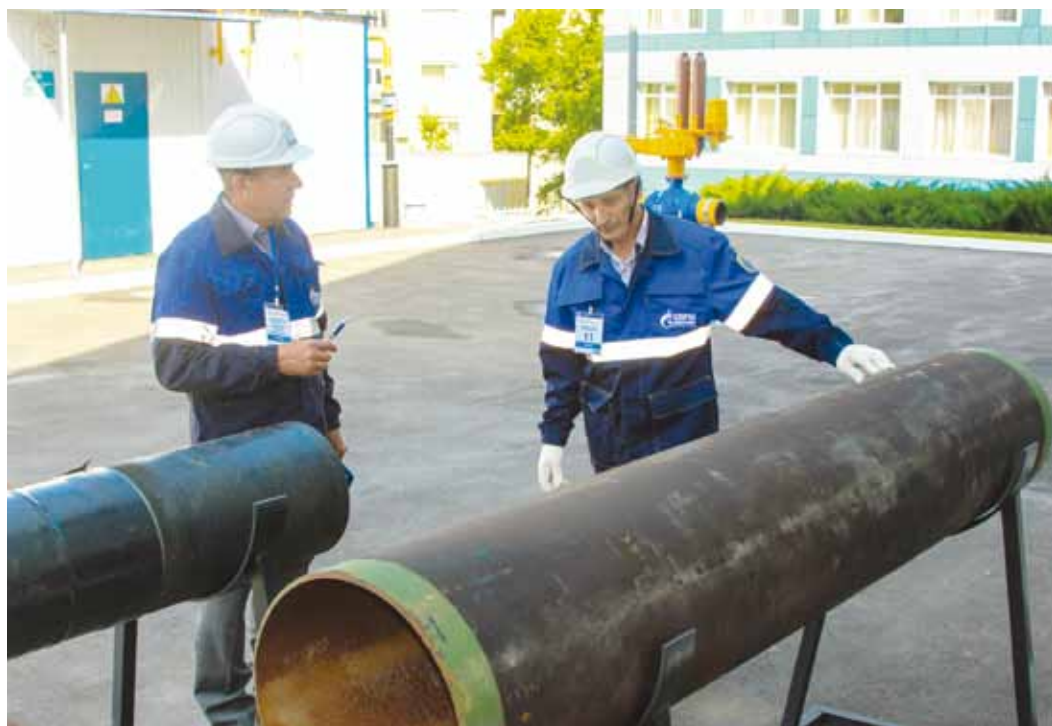
Определяется качество изоляционного покрытия
