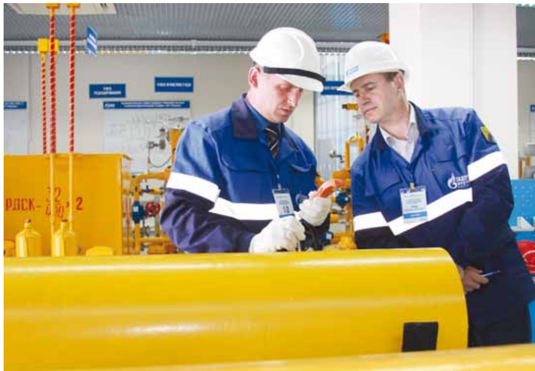
Проводится проверка нанесенных защитных лакокрасочных покрытий
