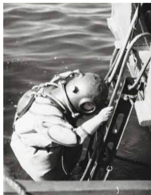
Строительство подводного перехода через Волгу
