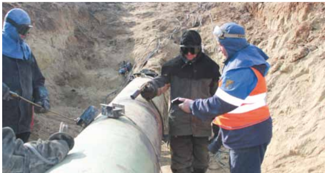
Подогрев тела трубы при постоянном контроле температуры
