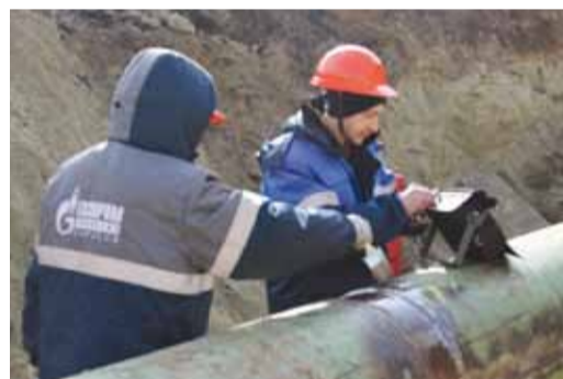
Подготовка к проведению УЗИ качества шва
