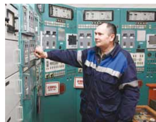
Инженер службы АИМО Н. Слепов: проверка системы загазованности «Щит-2» в цехе №3
