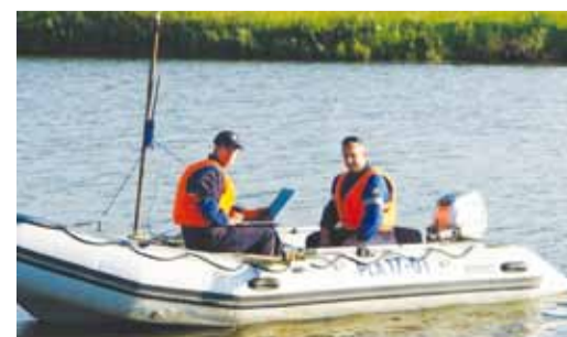
А.Зайцев (слева) ведет обследование подводного перехода газопровода, справа - специалист УАВР с правом управления маломерным судном
