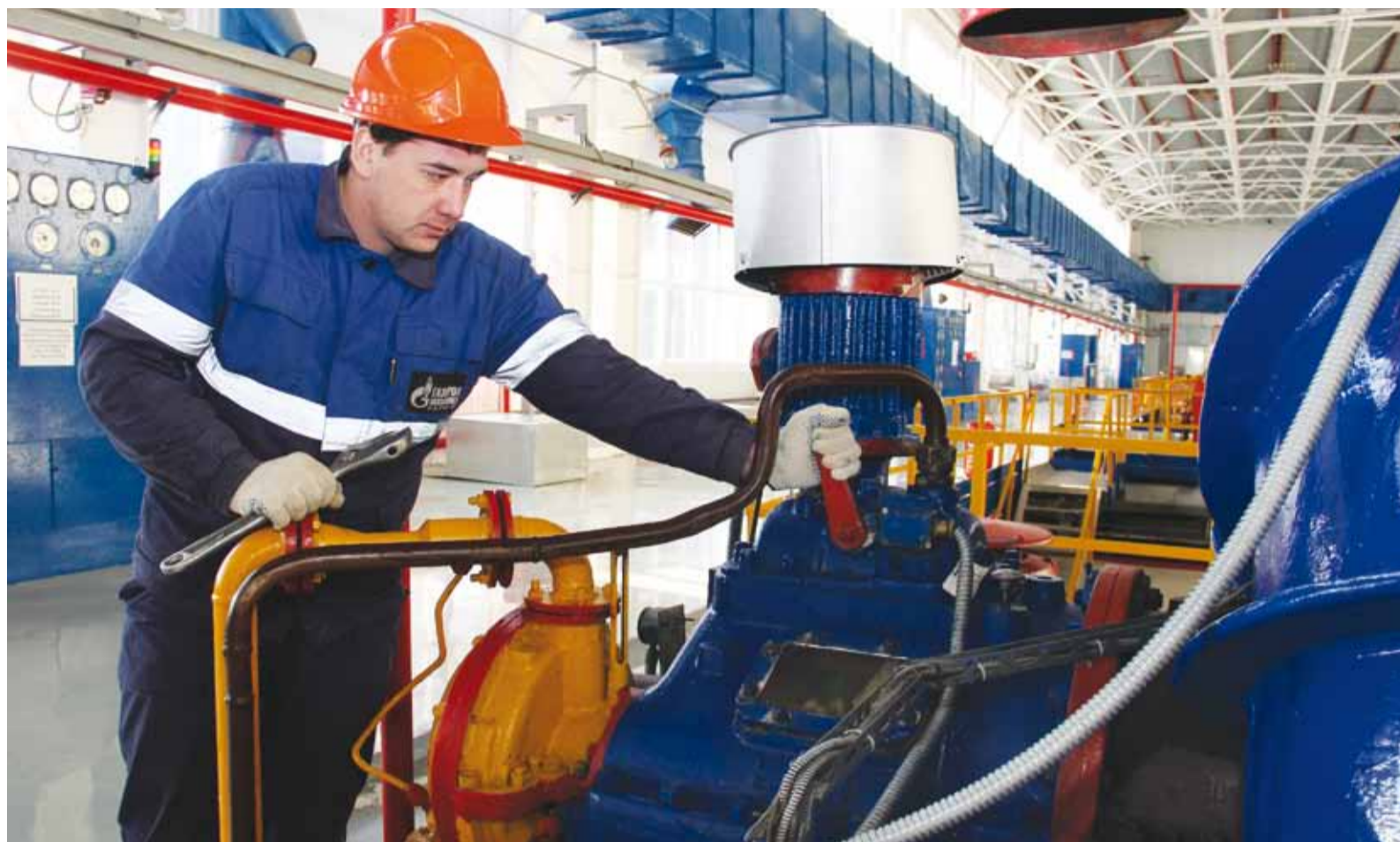
Машинист Вадим Сермягин выполняет техническое обслуживание турбоагрегатов в отремонтированном цехе
