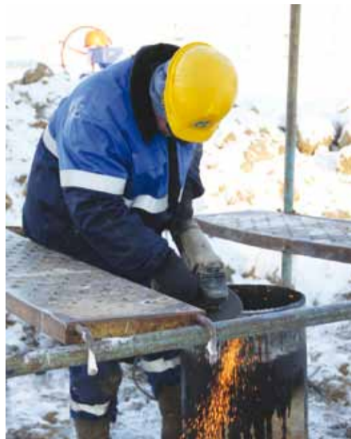
Не отстает от него и монтажник технологических трубопроводов УАВР Андрей Веремейчик
