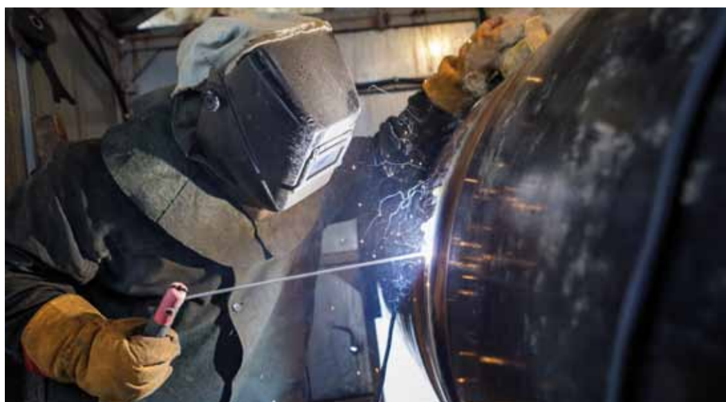
Сварка контрольно-сварных соединений
