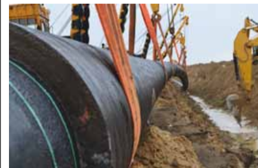
Укладка трубы с наномодифицированным цементно-песчаным покрытием. Фото ООО «БТ СВАП» prom.ru
