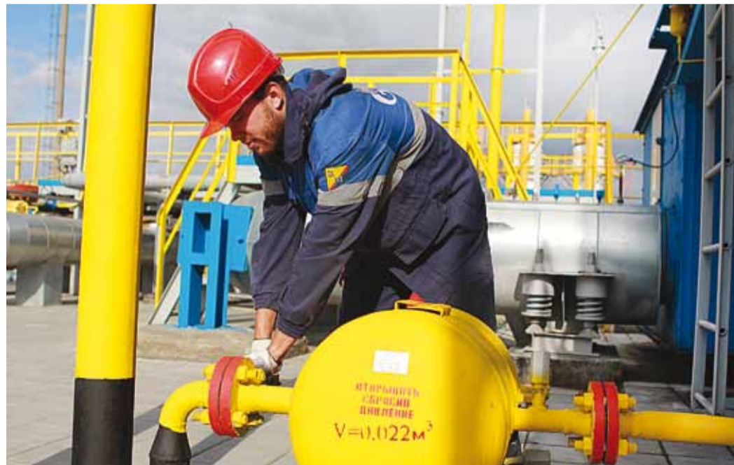
Машинист технологических компрессоров Матвей Чередников проводит ревизию фланцевого соединения топливного фильтра ГПА
