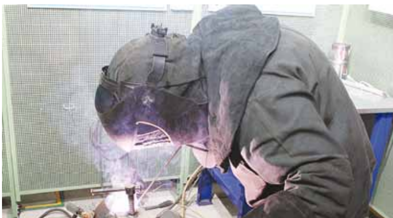
Сварка облицовочного слоя сварочного шва
