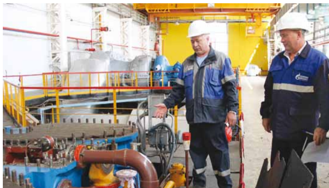
Мастер подрядной организации А.Ретин показывает ход ремонта агрегата начальнику ГКС Ю.Тимонину
