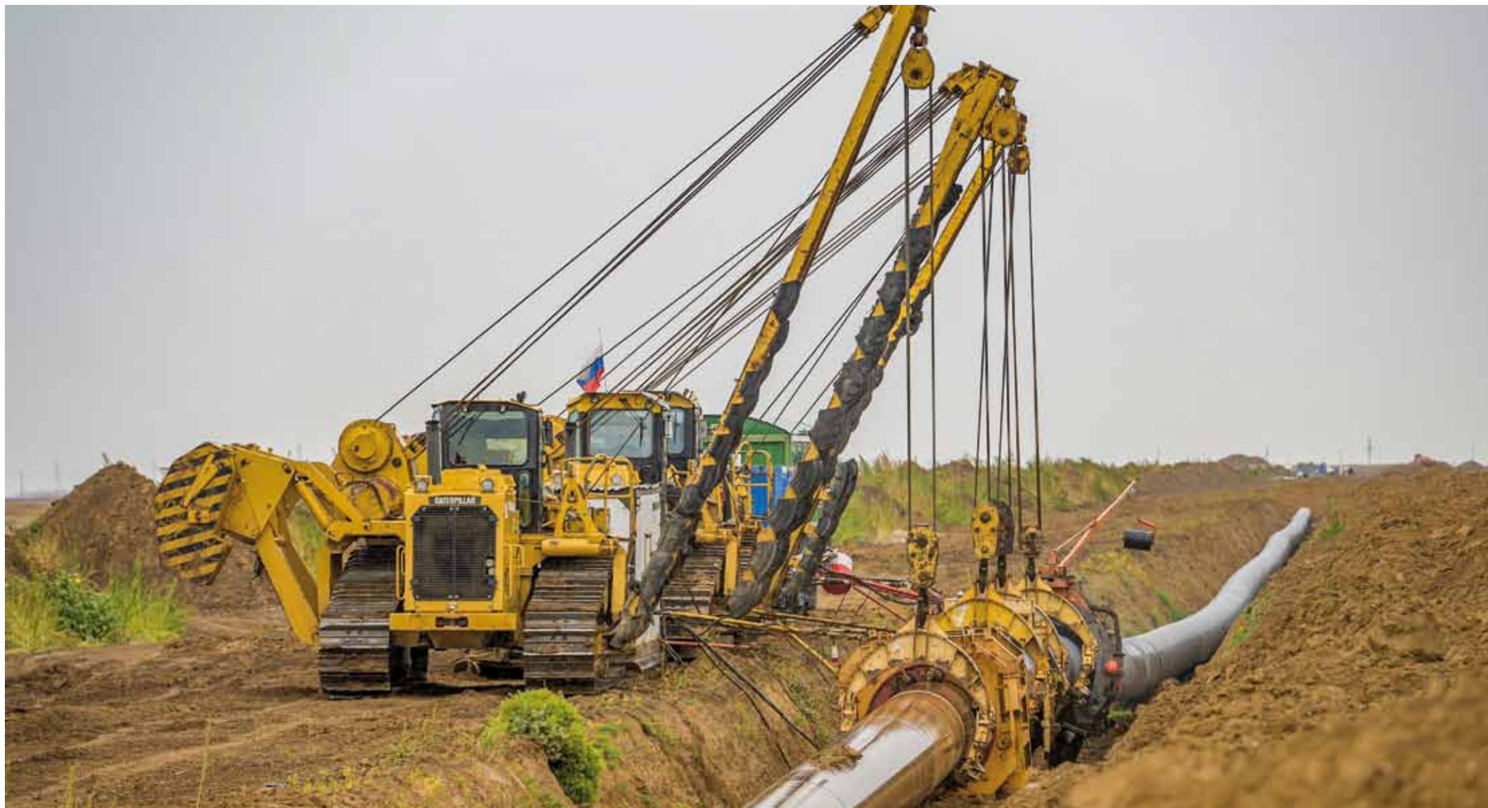
Капитальный ремонт магистрального газопровода Оренбург-Новопсков
