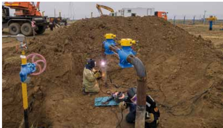
Огневые работы на узле подключения КЦ-5
