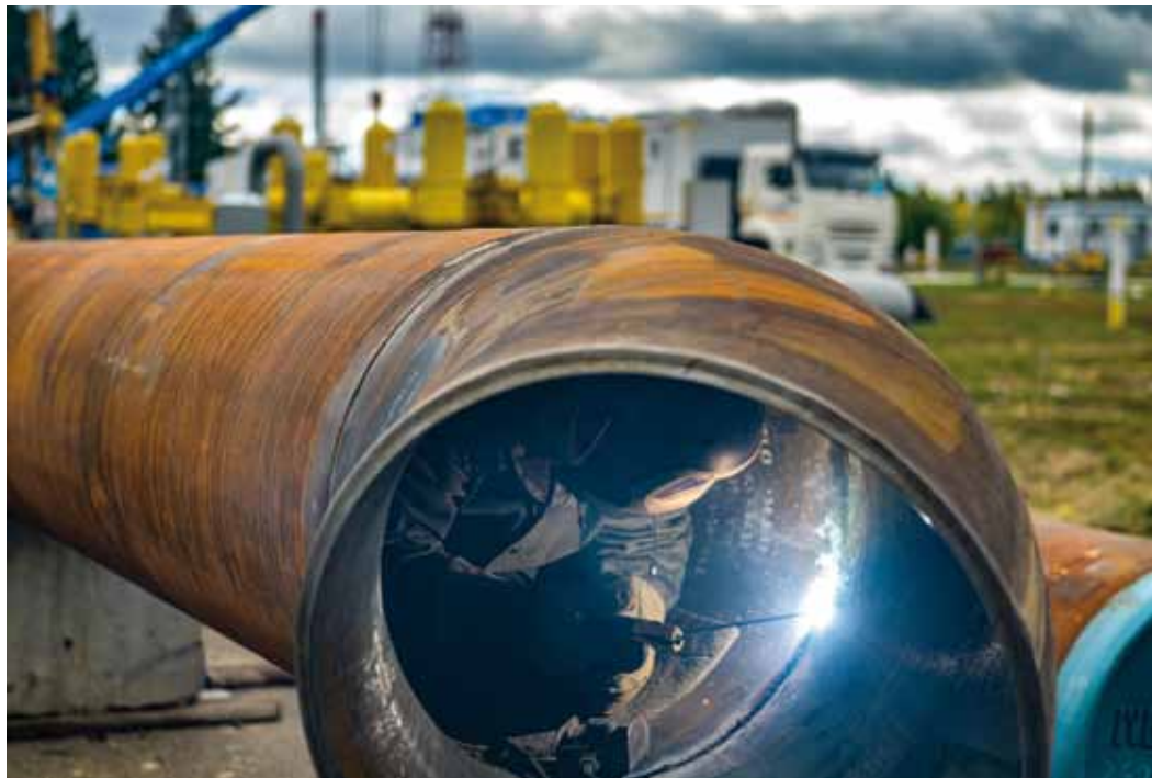
Огневые работы. Сварка подвального шва отвода.
