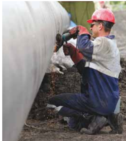
Работник подрядной организации проводит очистку стыков
